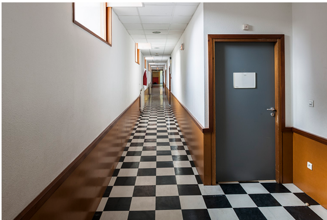
Couloir du 2ème étage de l'externat.
