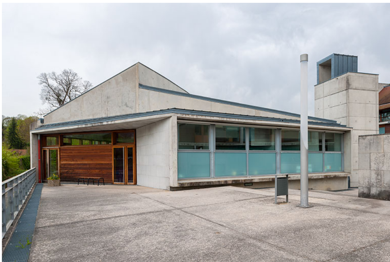
Façade sud-ouest du restaurant d'application.
