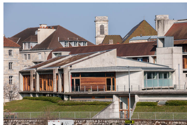
Restaurant d'application vu du sud-ouest.
