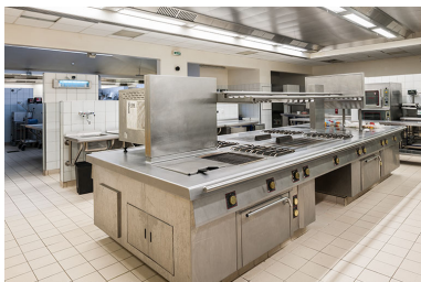
Cuisine du restaurant d'application. Phot. Jérôme Mongreville IVR43_20142500473NUC4A
