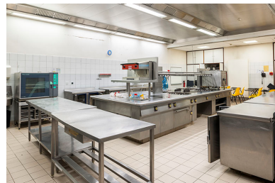
Cuisine du restaurant d'application. Phot. Jérôme Mongreville IVR43_20142500470NUC4A
