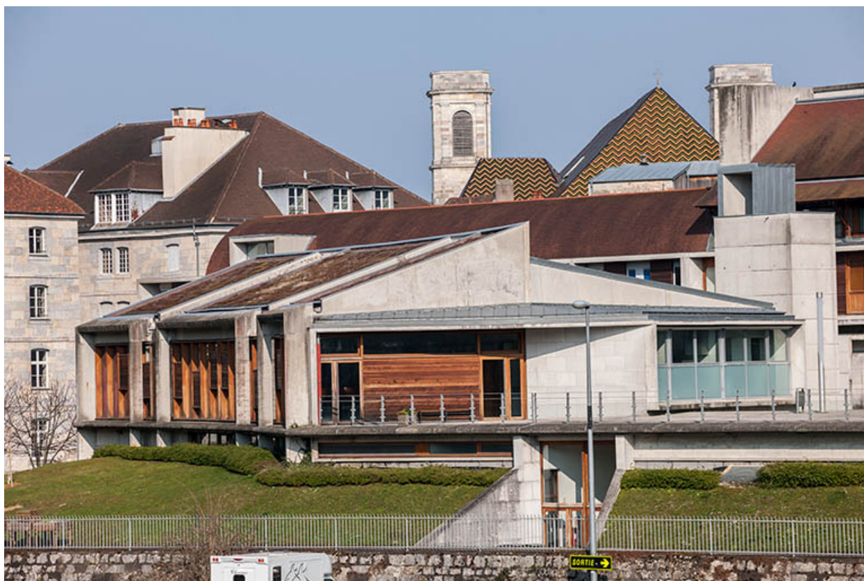
Restaurant d'application vu du sud-ouest.
