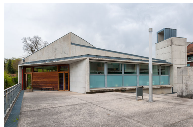
Façade sud-ouest du restaurant d'application.
