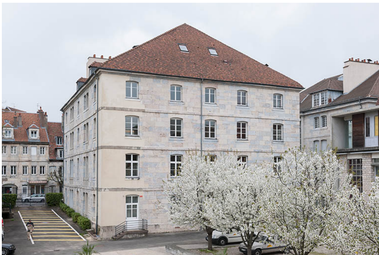
Angle sud-ouest du pavillon des officiers ouest.
