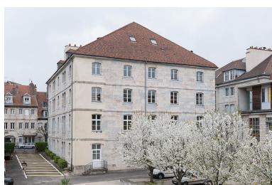
Angle sud-ouest du pavillon des officiers ouest.
