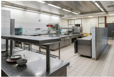
Cuisine du restaurant d'application. Phot. Jérôme Mongreville IVR43_20142500471NUC4A
