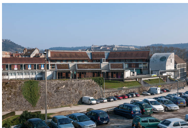
Vue d'ensemble des parties sud depuis l'ouest. Phot. Jérôme Mongreville IVR43_20142500430NUC4A
