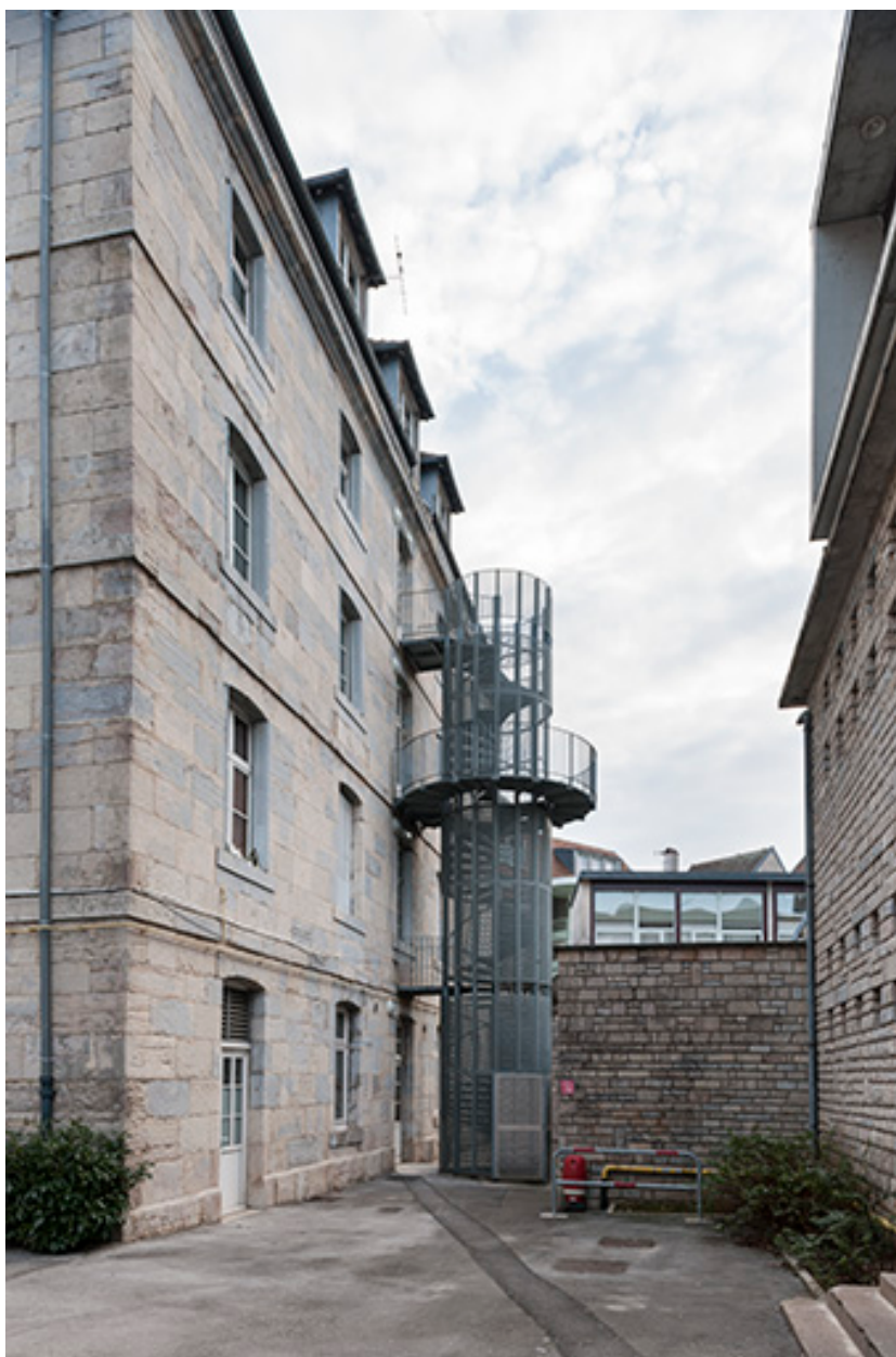
Escalier de distribution extérieur du pavillon est.
