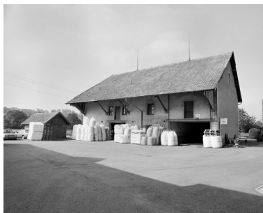
L'étable et la grange. Phot. Yves Sancey IVR43_20009000142X
