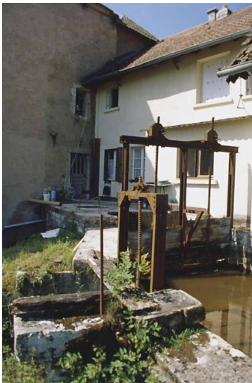
Vannage sur le canal d'aménée.
