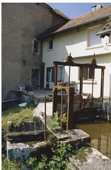
Vannage sur le canal d'amenée. Phot. Yves Sancey IVR43_20009000160ZA
