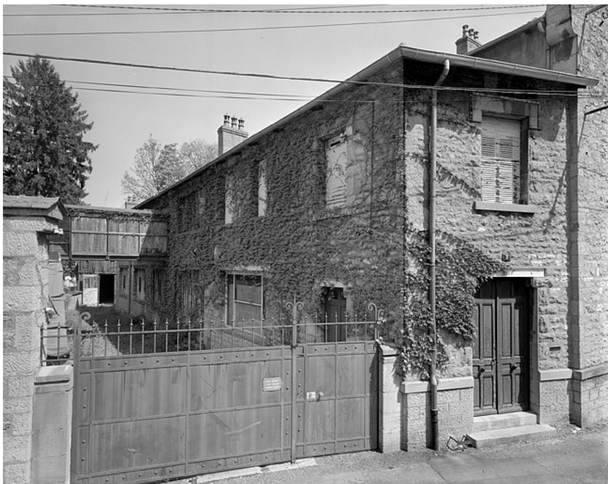
Elévation ouest depuis la rue.
