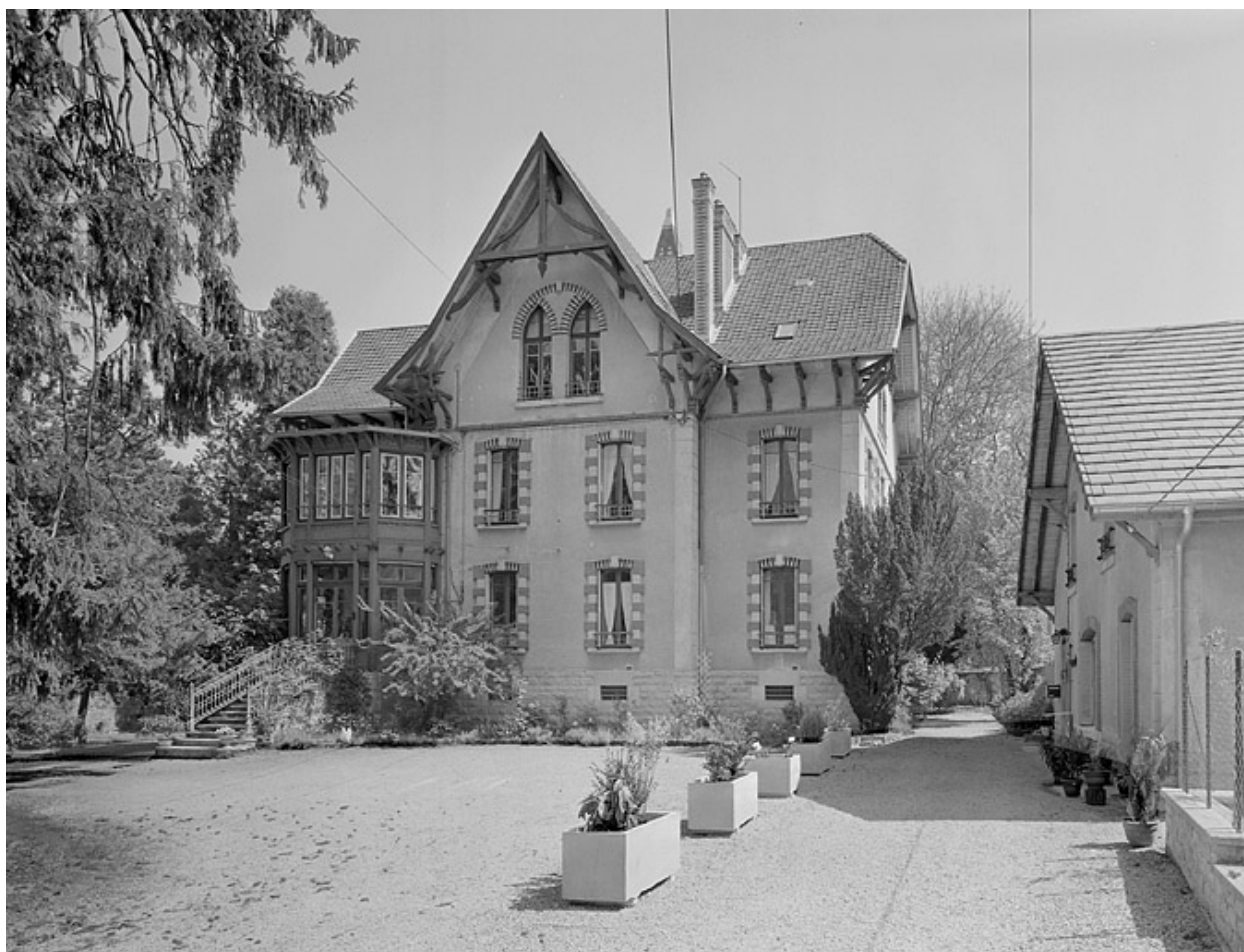
Logement patronal depuis l'ouest.
