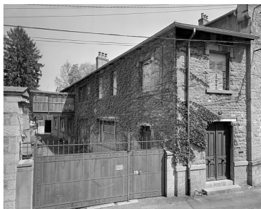
Elévation ouest depuis la rue. Phot. Jérôme Mongreville IVR43_19973900269V
