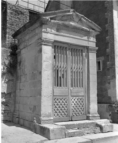
Vue d'ensemble extérieure. Phot. Michel Rosso IVR26_19748900922X
