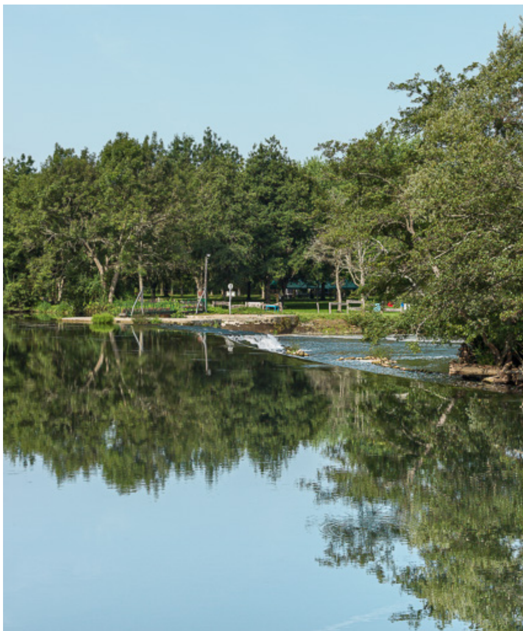
Vue du barrage à aiguilles.
