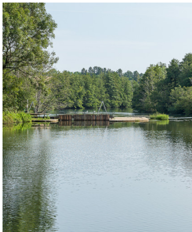
Vue d'ensemble du barrage à aiguilles.
