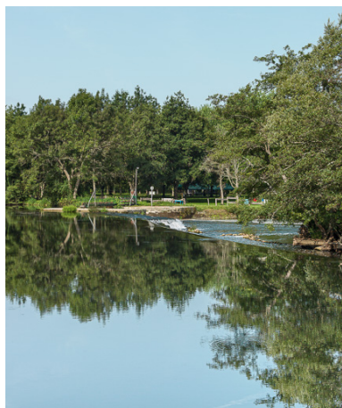
Vue du barrage à aiguilles.
