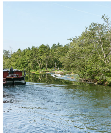
Vue du barrage à aiguilles.
