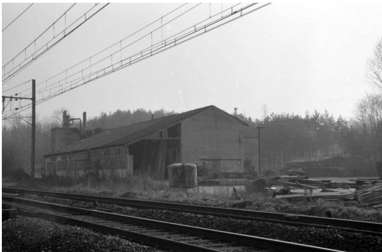
Menuiserie (M), depuis le nord-est.
