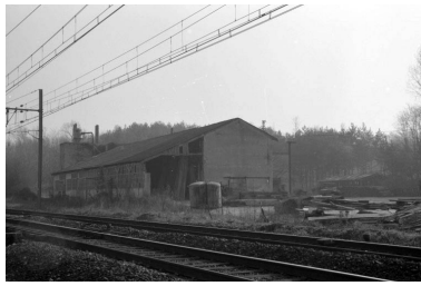
Menuiserie (M), depuis le nord-est. Phot. Laurent Poupard IVR43_19893900281Z
