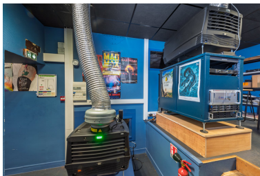
Cabine de projection : projecteurs Barco DP2K12C. Phot. Pierre-Marie Barbe-Richaud IVR26_20245800274NUC4A
