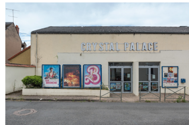
Façade antérieure : entrée. Phot. Pierre-Marie Barbe-Richaud IVR26_20235800215NUC4A
