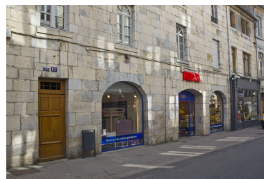
Logis principal : rez-de-chaussée de la façade sur rue, de trois quarts gauche.
