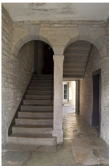
escalier dans oeuvre.
