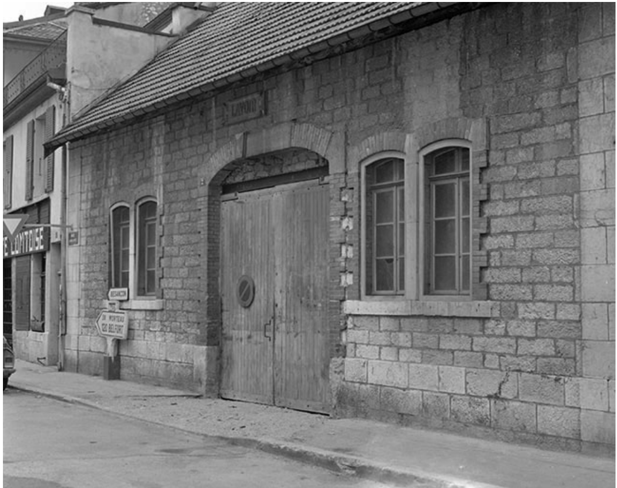
Façade sur rue, vue de trois quarts.
