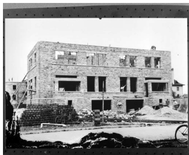
Travaux de construction de la maison, façade antérieure. Phot. , Phot. Charnotet IVR43_19903900112X
