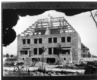
Travaux de construction de la maison, façade antérieure. Phot. , Phot. Charnotet IVR43_19903900113X
