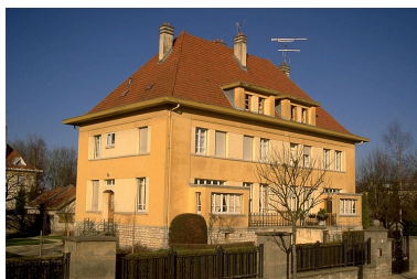
Façade antérieure et face gauche. Phot. Laurent Poupard IVR43_19893900504ZA
