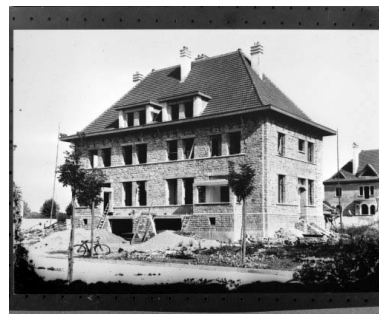
Travaux de construction de la maison, façade antérieure. Phot. , Phot. Charnotet IVR43_19903900114X
