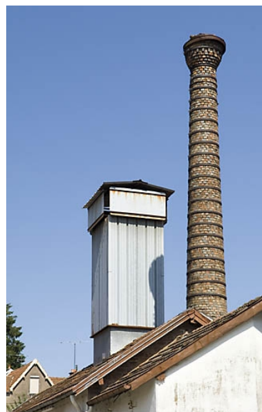
Détail des cheminées. Phot. Jérôme Mongreville IVR43_20077000185NUCA
