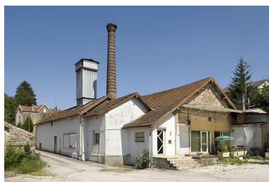
Vue depuis l'ouest. Phot. Jérôme Mongreville IVR43_20077000186NUCA
