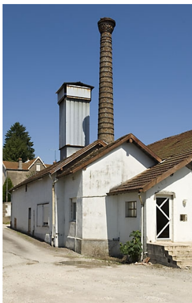
Atelier de fabrication et cheminées. Phot. Jérôme Mongreville IVR43_20077000184NUCA
