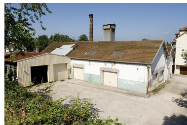
Vue depuis l'est. Phot. Jérôme Mongreville IVR43_20077000183NUCA
