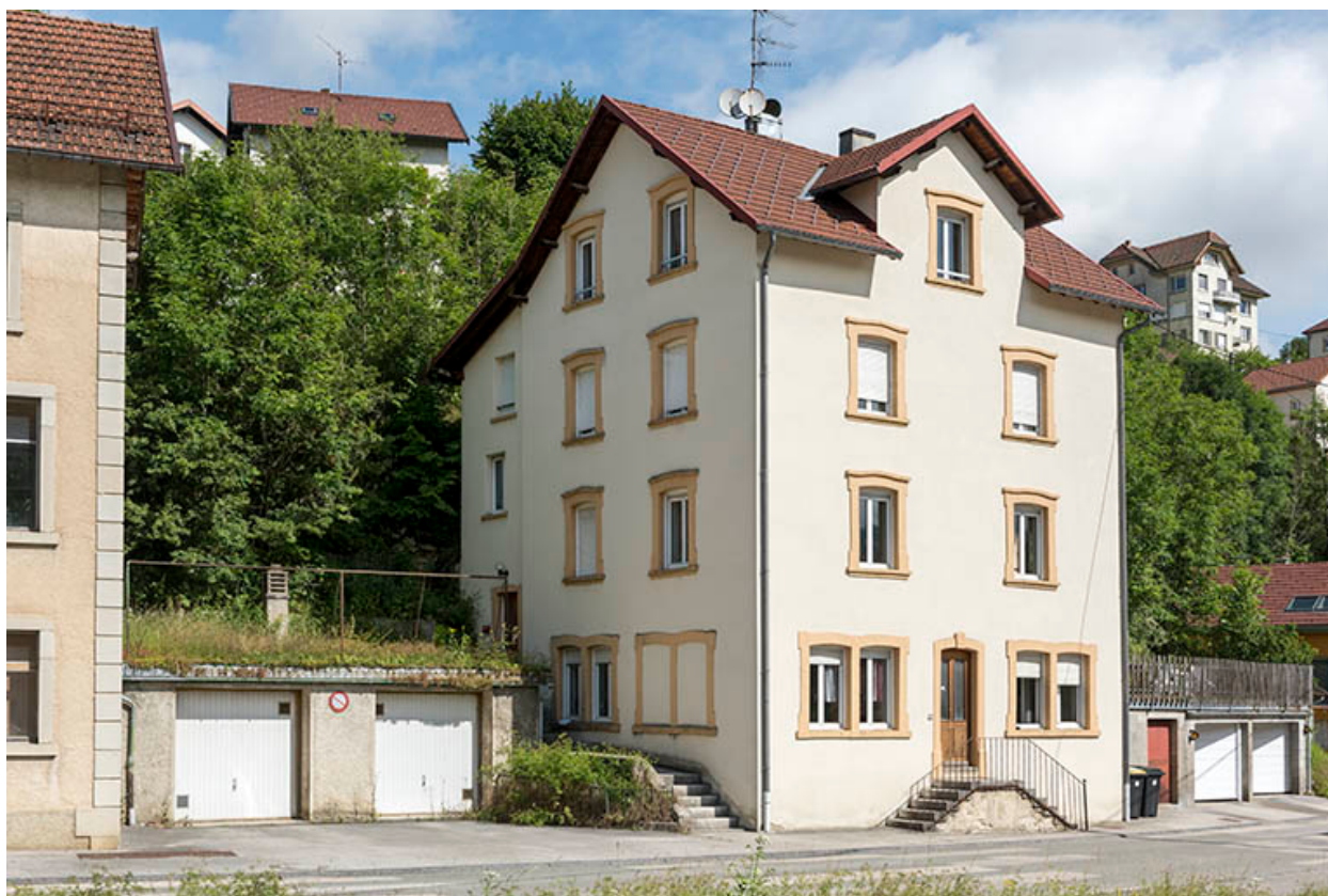
Façades antérieure et latérale gauche.
