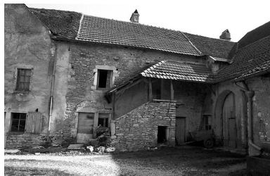
Vue d'ensemble. Phot. Bernard Lardière IVR43_19797000109Z
