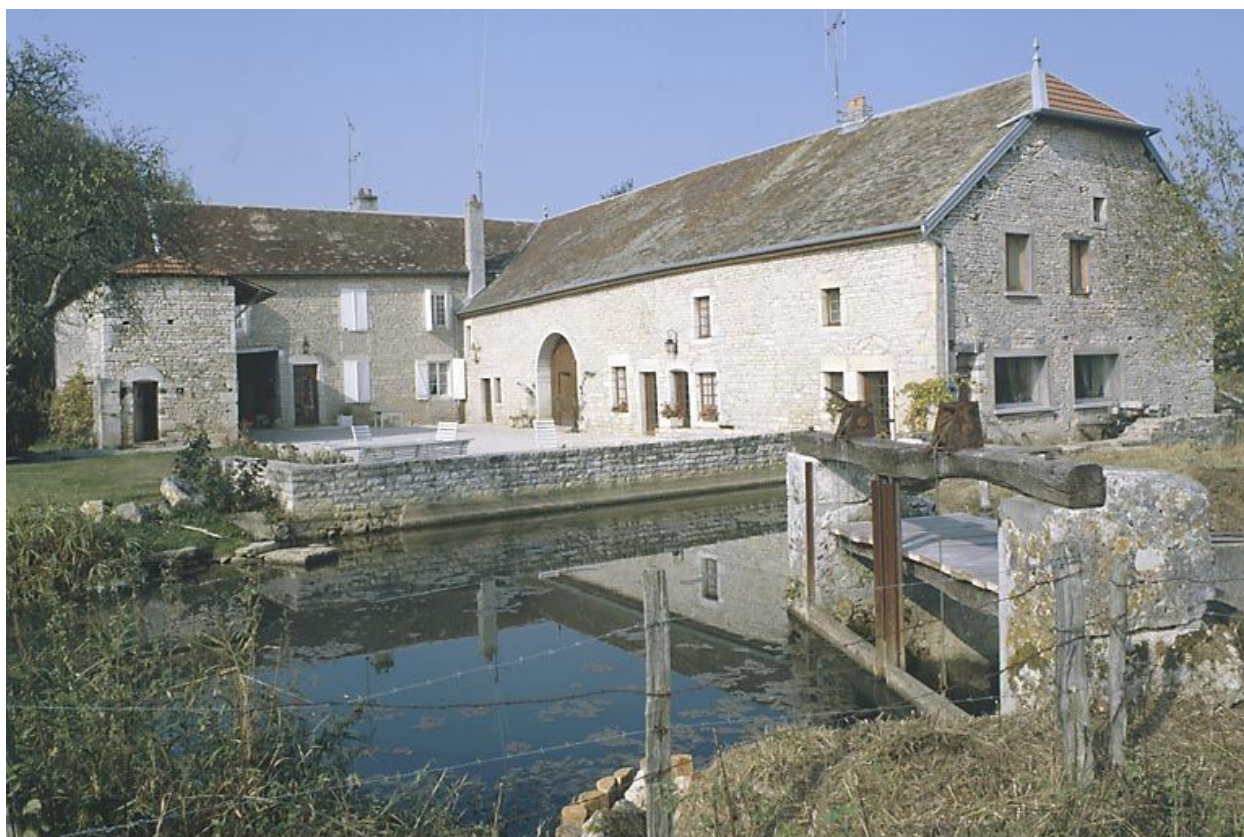
Vue d'ensemble des bâtiments.
