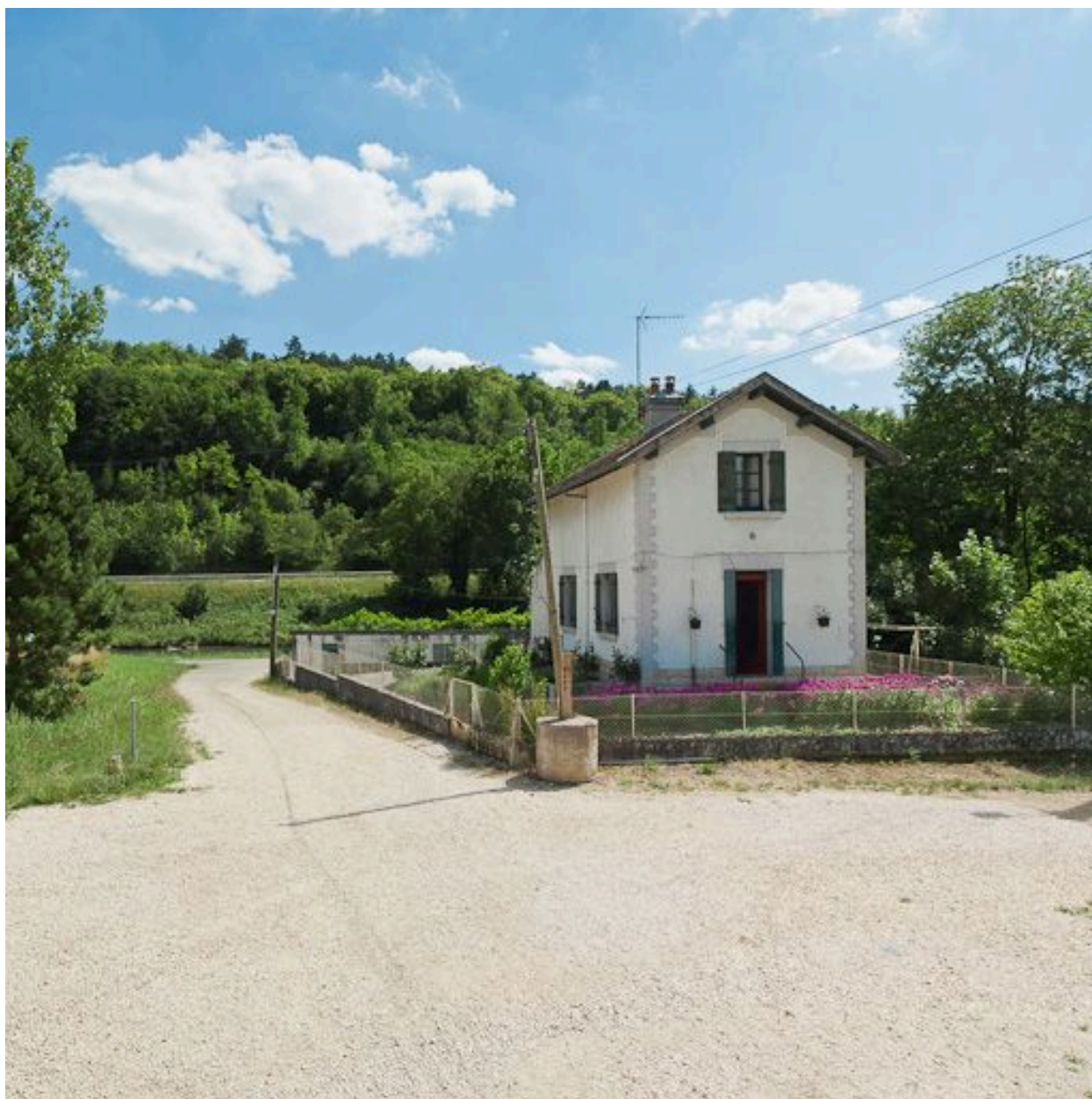
Vue de la maison de garde-barrière.
