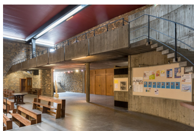
Tribune sud. Vue de trois quarts. En haut, l'une des quatre ouvertures zénithales. Phot. Pierre-Marie Barbe-Richaud IVR43_20222500376NUC4A
