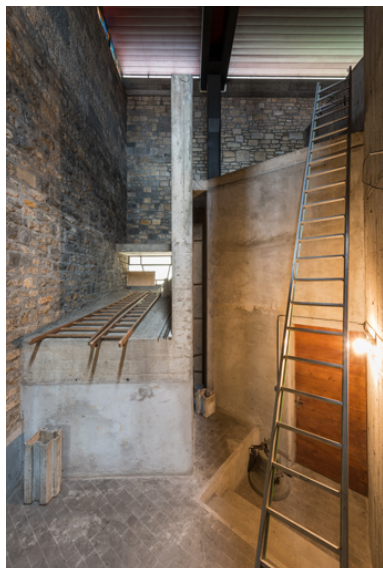
Accès intérieur au dépositaire. A gauche, le couvrement de l'escalier menant à la salle paroissiale Saint-Boniface. Phot. Pierre-Marie Barbe-Richaud IVR43_20222500377NUC4A
