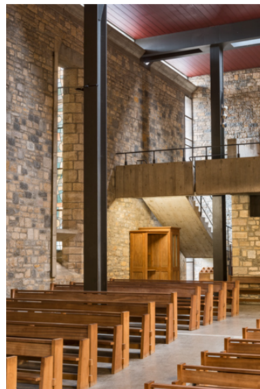
Angle sud-est de l'église. À gauche, la verrière en vitrail de la baie latérale. Au second plan, l'escalier d'accès à la tribune sud. Phot. Pierre-Marie Barbe-Richaud IVR43_20222500345NUC4A
