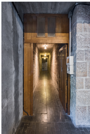
Couloir situé derrière le mur du chœur de l'église et reliant la sacristie à la chapelle. Vue depuis la chapelle. Phot. Pierre-Marie Barbe-Richaud IVR43_20222500334NUC4A
