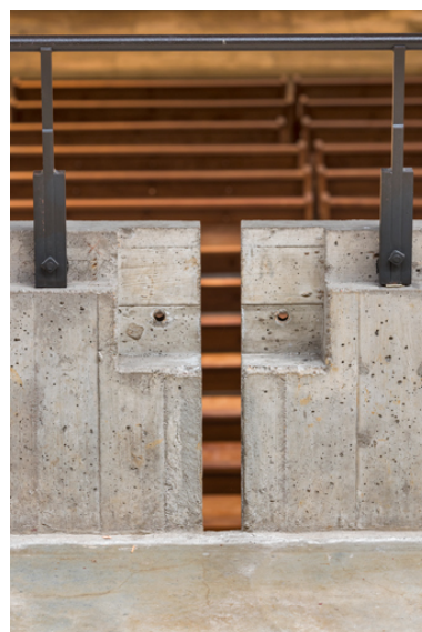
Garde-corps de la tribune sud. Détail. Phot. Pierre-Marie Barbe-Richaud IVR43_20222500371NUC4A
