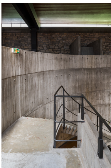
Mur rideau courbe séparant le dépositaire de la nef. Au premier plan, l'escalier courbe de la tribune sud. Phot. Pierre-Marie Barbe-Richaud IVR43_20222500375NUC4A
