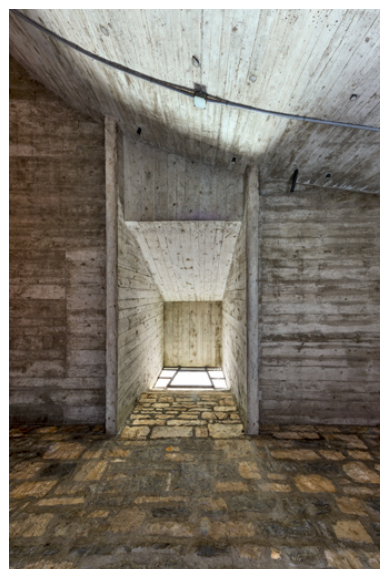
Puits de lumière dans le dépositaire. Vue en contreplongée. Phot. Pierre-Marie Barbe-Richaud IVR43_20222500382NUC4A
