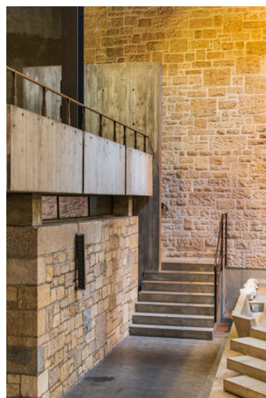
Escalier d'accès à la tribune ouest. Phot. Pierre-Marie Barbe-Richaud IVR43_20222500363NUC4A
