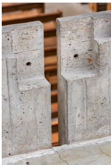
Garde-corps de la tribune sud. Détail de trois-quarts. Phot. Pierre-Marie Barbe-Richaud IVR43_20222500372NUC4A
