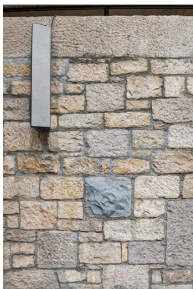
Maçonnerie du mur de la tribune ouest en appareil assisé. Détail. Phot. Pierre-Marie Barbe-Richaud IVR43_20222500380NUC4A
