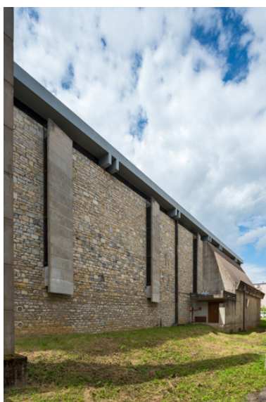
Façade sud-est. À droite, le voile oblique couvrant la tribune d'orgue. Phot. Pierre-Marie Barbe-Richaud
