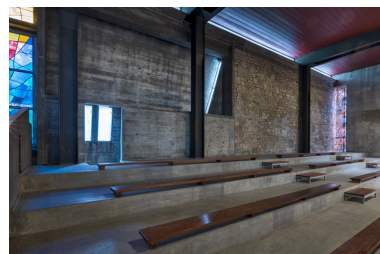
Tribune ouest. Vue en direction du mur ouest, de trois quarts. Phot. Pierre-Marie Barbe-Richaud IVR43_20222500328NUC4A
