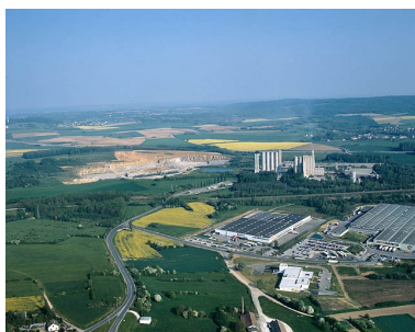
Vue aérienne, depuis le sud. Phot. Yves Sancey IVR43_19903900270XA
