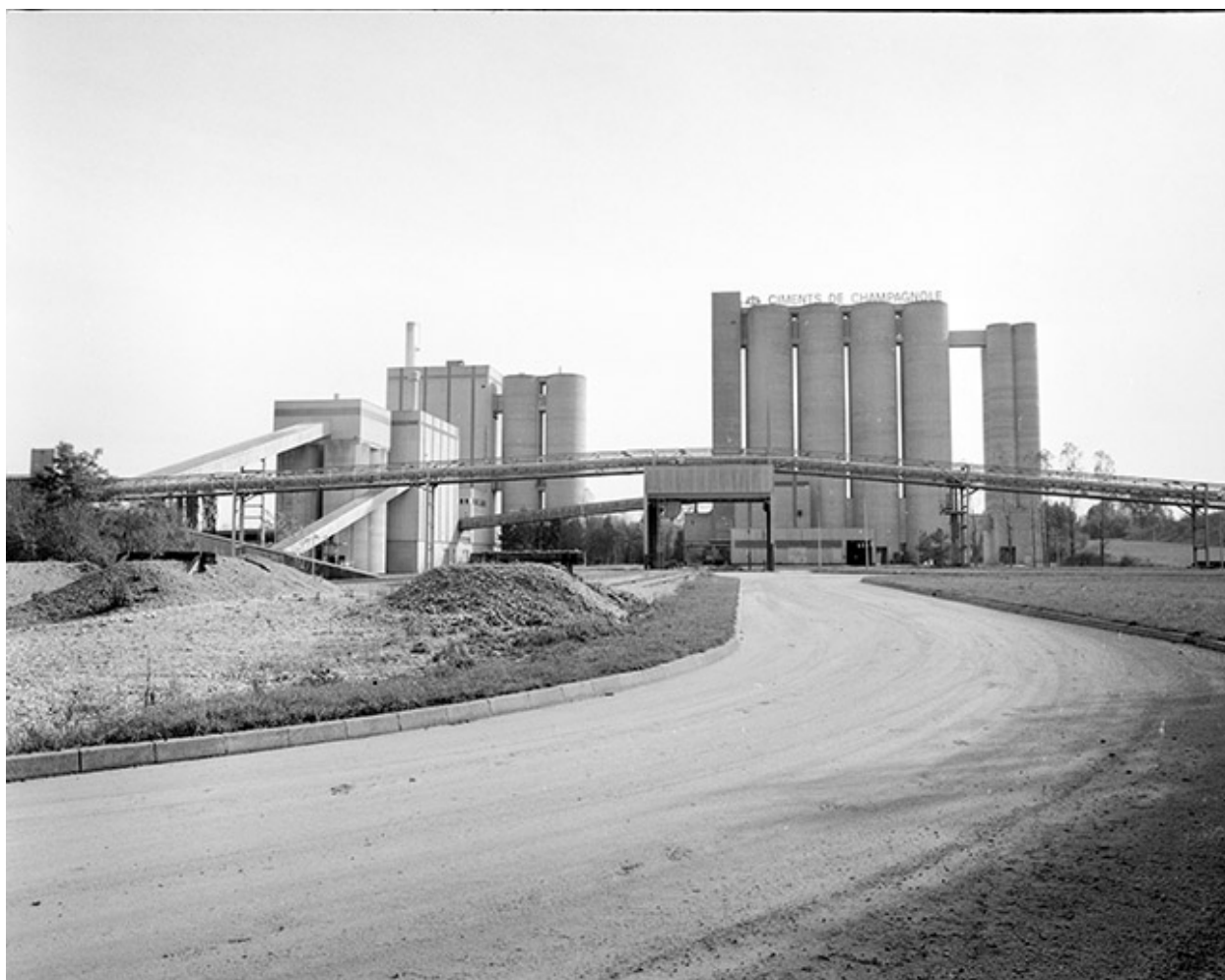
Vue d'ensemble depuis le nord-ouest : transporteur à bande, atelier de fabrication à gauche, silos et conditionnement à droite.
