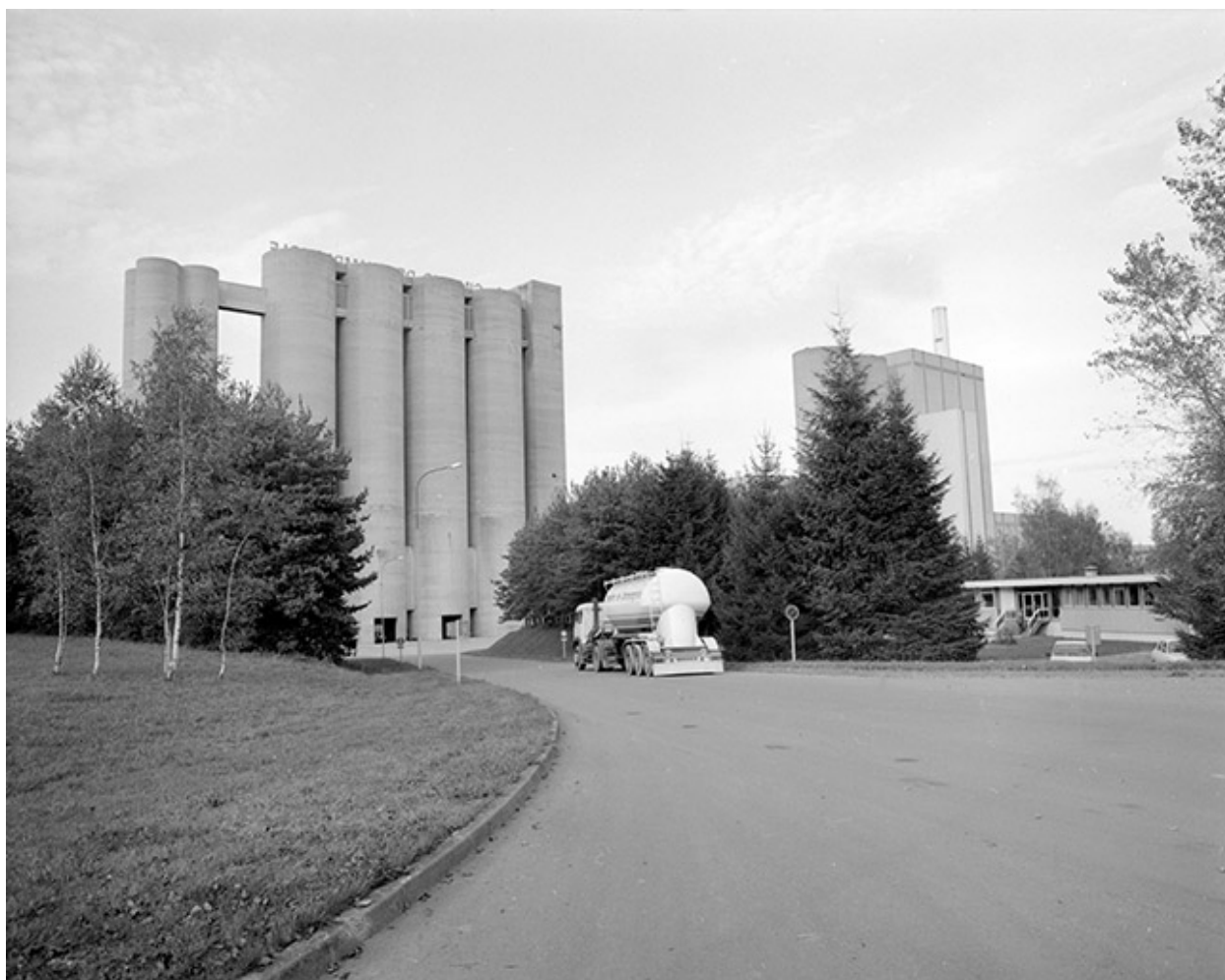
Entrée de l'usine.
