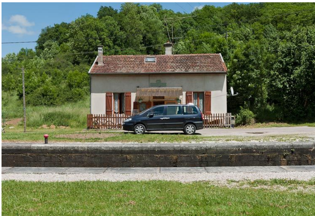
Maison éclusière vue de face.
