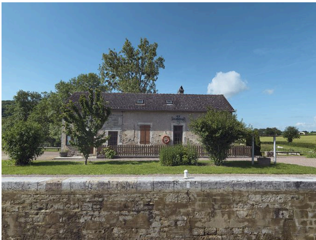
Maison éclésièr de face.
