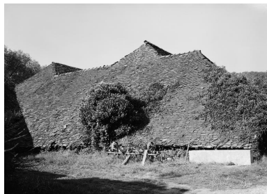
Halle de séchage, côté cour. Phot. Jean-Luc Duthu IVR26_19792101524V
