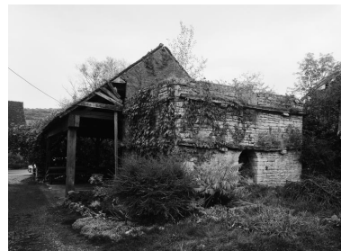
Bâtiment du four et four : élévation postérieure. Phot. Michel Thierry IVR26_19792101525V
