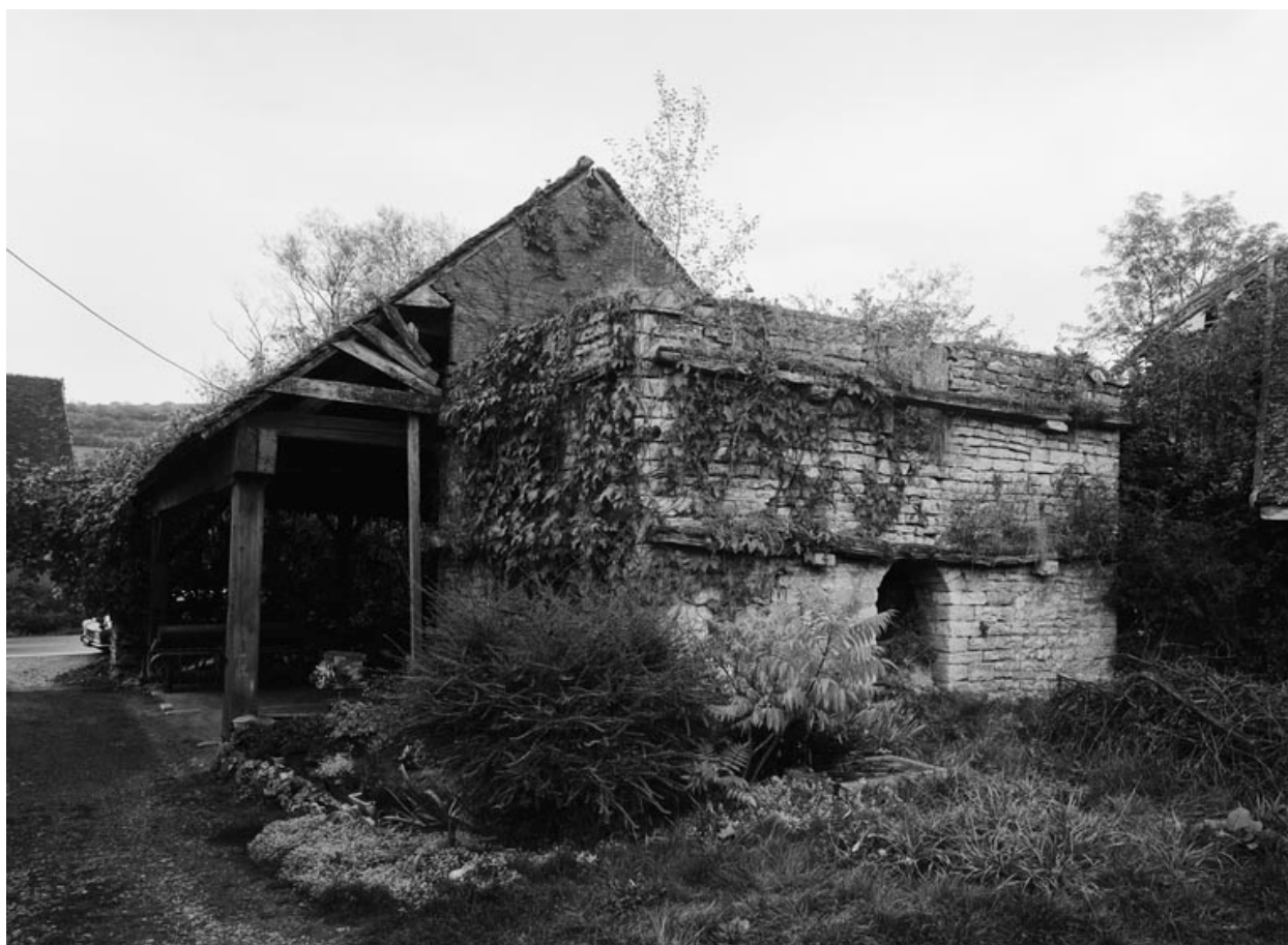
Bâtiment du four et four : élévation postérieure.
