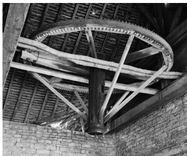
Détail de la roue servant à malaxer la terre glaise. Phot. Michel Thierry IVR26_19792101526X
