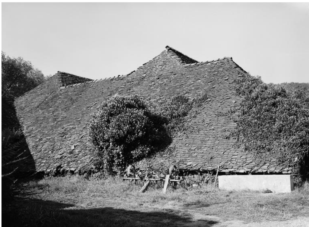
Halle de séchage, côté cour.
