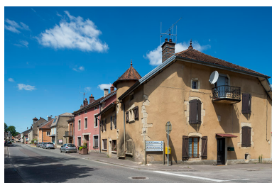
Côté est, maisons n° 43-45, vue vers le nord depuis le pont sur la Saône. Phot. Jérôme Mongreville IVR43_20187000448NUC4A
