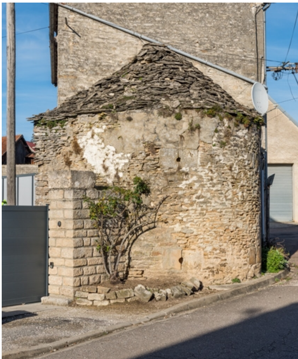
Vue de la tour depuis le sud-ouest.
