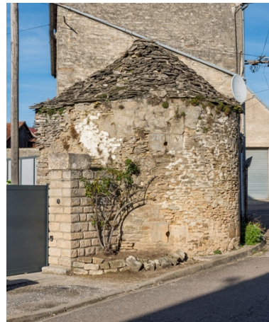
Vue de la tour depuis le sud-ouest. Phot. Pierre-Marie Barbe-Richaud IVR26_20222101101NUC2A
