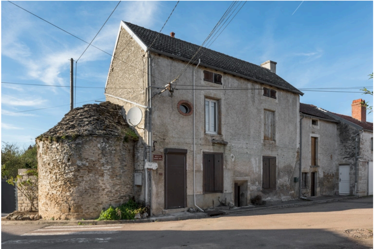
Vue d'ensemble depuis le sud.
