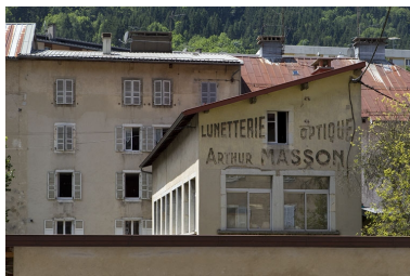
Ateliers : mur pignon oriental.
