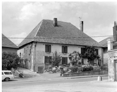
Façades antérieure et latérale gauche.
