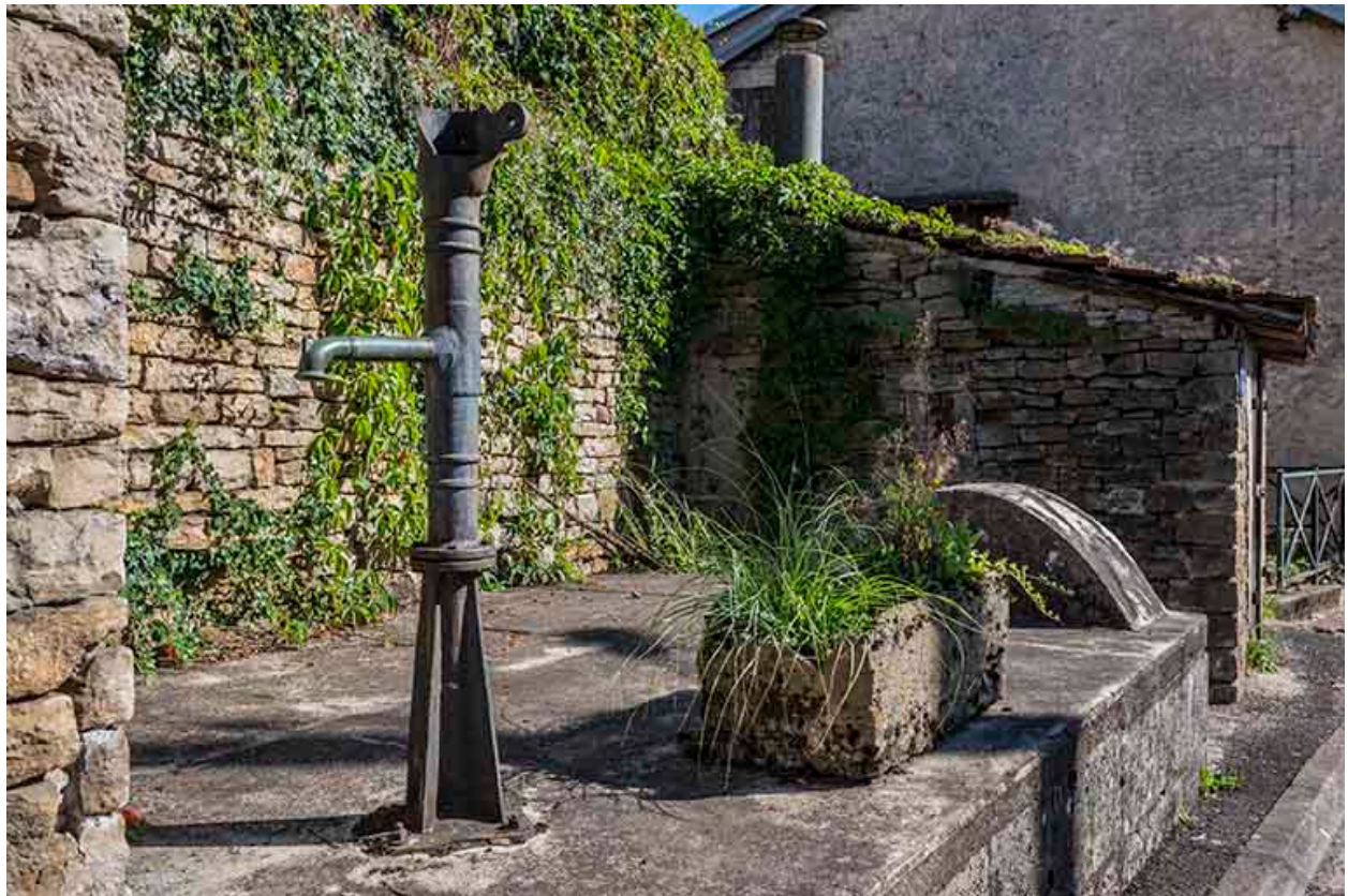
La pompe en fonte.
