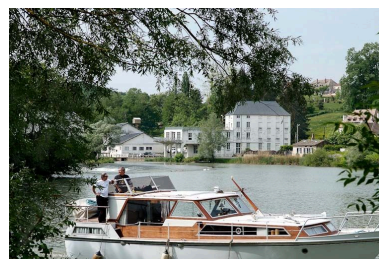
Les bâtiments modernes du moulin vus d'amont. Bateau de plaisance au premier plan. Phot. Jean-Luc Duthu IVR26_20107100396NUC2A
