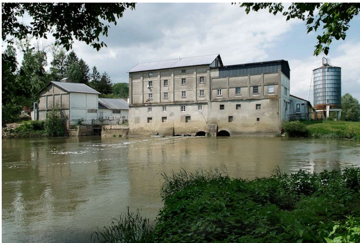
Le moulin : vue d'ensemble d'aval.
