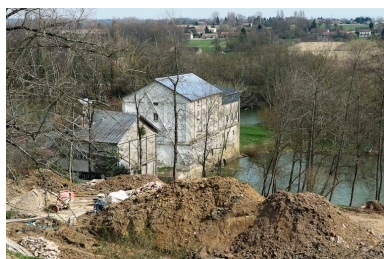
Le moulin vu du dessus. Phot. Jean-Luc Duthu IVR26_20107100397NUC2A
