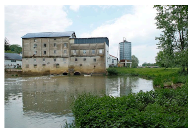
Le moulin vu d'aval. Phot. Jean-Luc Duthu IVR26_20107100399NUC2A
