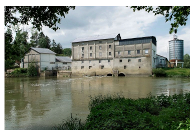
Le moulin : vue d'ensemble d'aval. Phot. Jean-Luc Duthu IVR26_20107100398NUC2A
