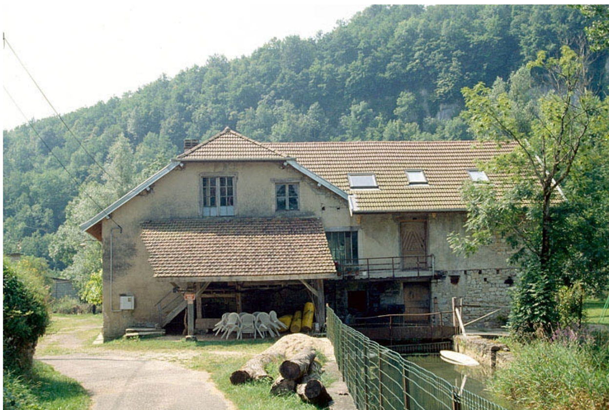
Moulin et tournerie, vus du nord.
