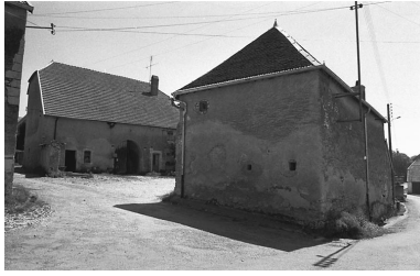
Vue d'ensemble. Phot. Bernard Lardière IVR43_19817000129Z
