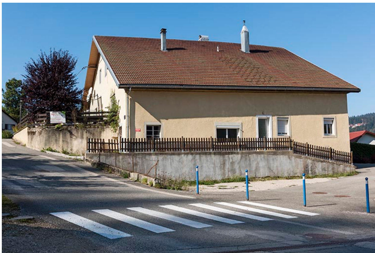
Façade latérale droite, de trois quarts gauche.
