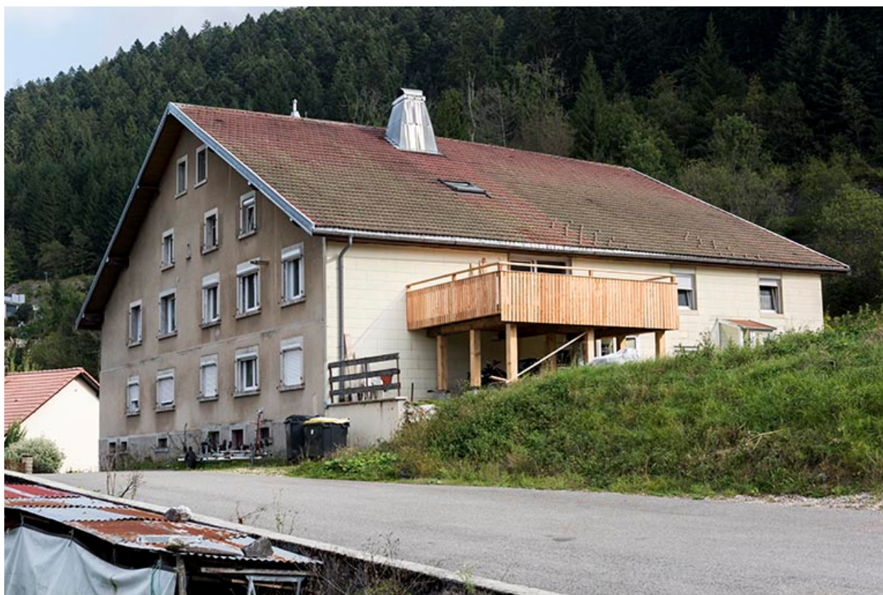
Façades postérieure et latérale gauche.
