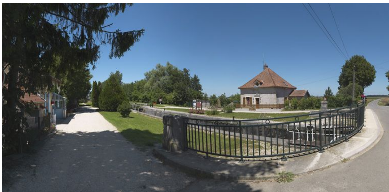
La maison éclusière.
