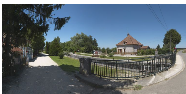
La maison éclusière. Phot. Thierry Kuntz IVR26_20112103158NUC4A
