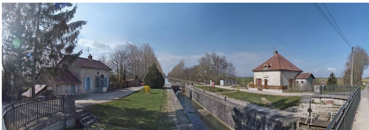
Vue panoramique du site avec les deux maisons.
