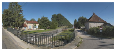
Vue d'ensemble du site, prise d'aval. Phot. Thierry Kuntz IVR26_20112103156NUC4A
