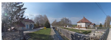
Vue panoramique du site avec les deux maisons. Phot. Thierry Kuntz IVR26_20112103159NUC4A
