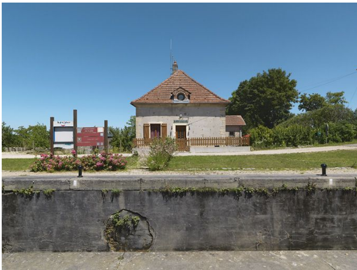
Maison éclusière vue de face.
