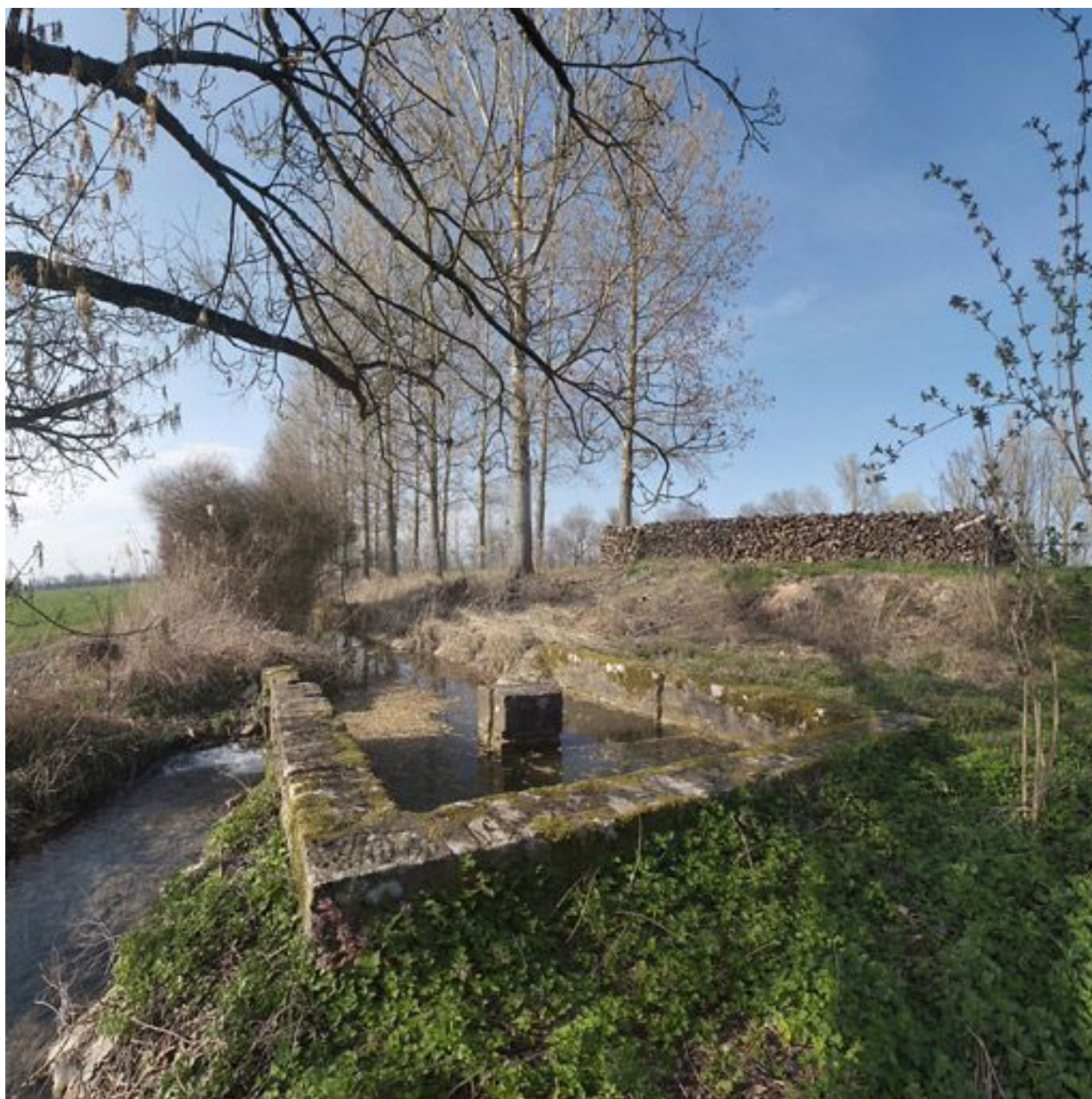
Bassin maçonné recevant les eaux du contre-fossé et celles de l'aqueduc passant sous l'écluse.
