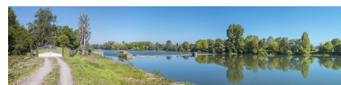
Vue d'ensemble de l'ancien barrage depuis la rive gauche. La maison du barragiste est derrière le portail, à gauche. Phot. Thierry Kuntz IVR26_20172100219NUC4A
