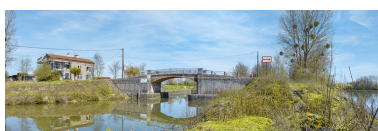
Vue d'ensemble d'aval : à gauche, la maison éclusière et à droite, la Saône. Phot. Thierry Kuntz IVR26_20162101440NUC4A
