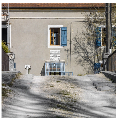
Maison éclusière : vue rapprochée sur la plaque. Phot. Thierry Kuntz IVR26_20162101444NUC4A
