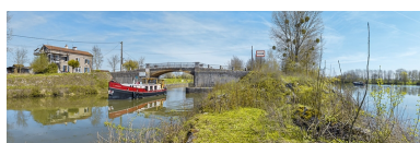
Vue d'ensemble d'aval : à gauche, la maison éclusière et à droite, la Saône. Phot. Thierry Kuntz IVR26_20162101439NUC4A
