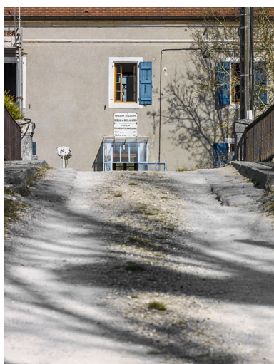
Maison éclusière : vue rapprochée sur la plaque. Phot. Thierry Kuntz IVR26_20162101443NUC4A
