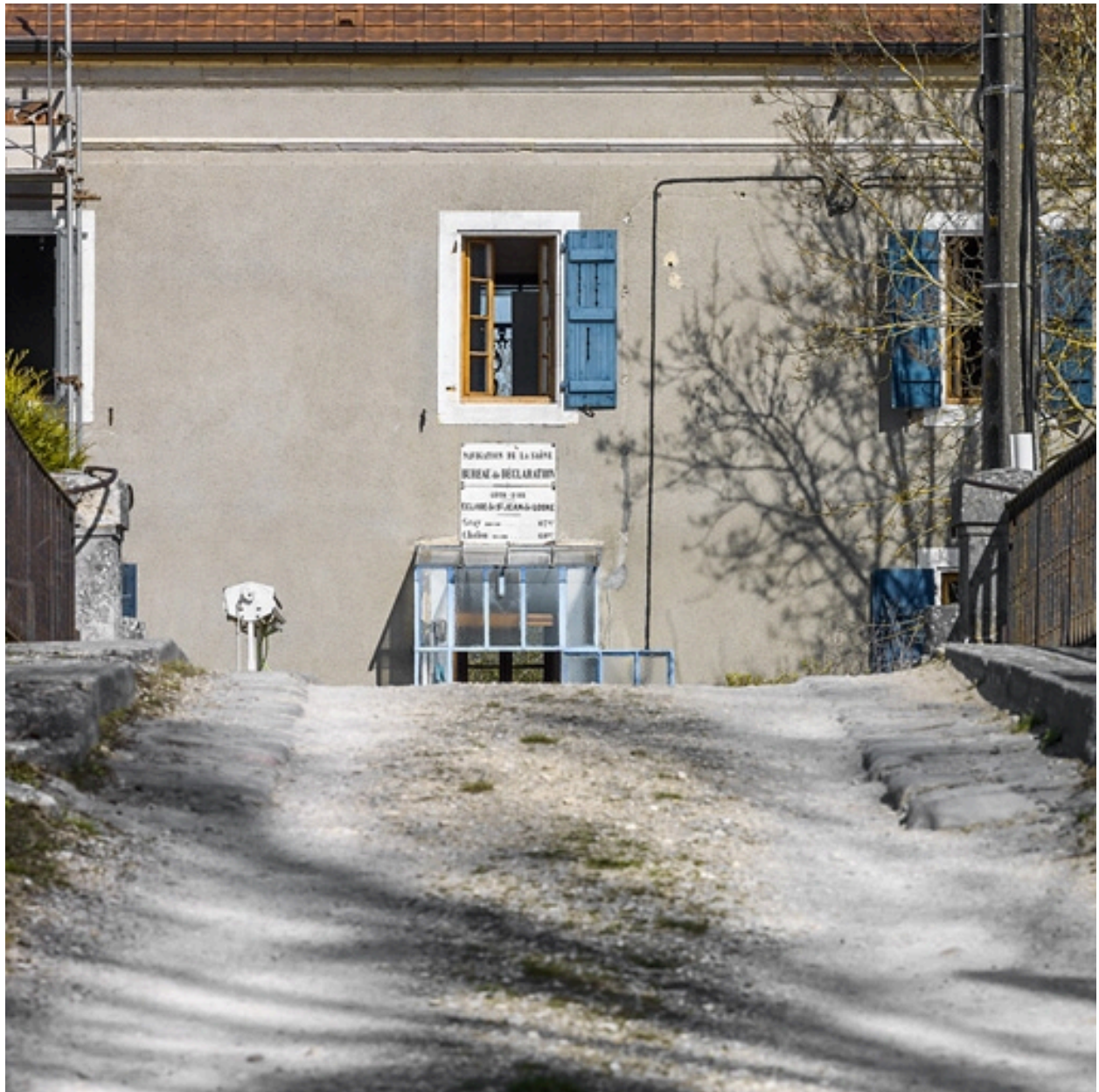
Maison éclusière : vue rapprochée sur la plaque.
