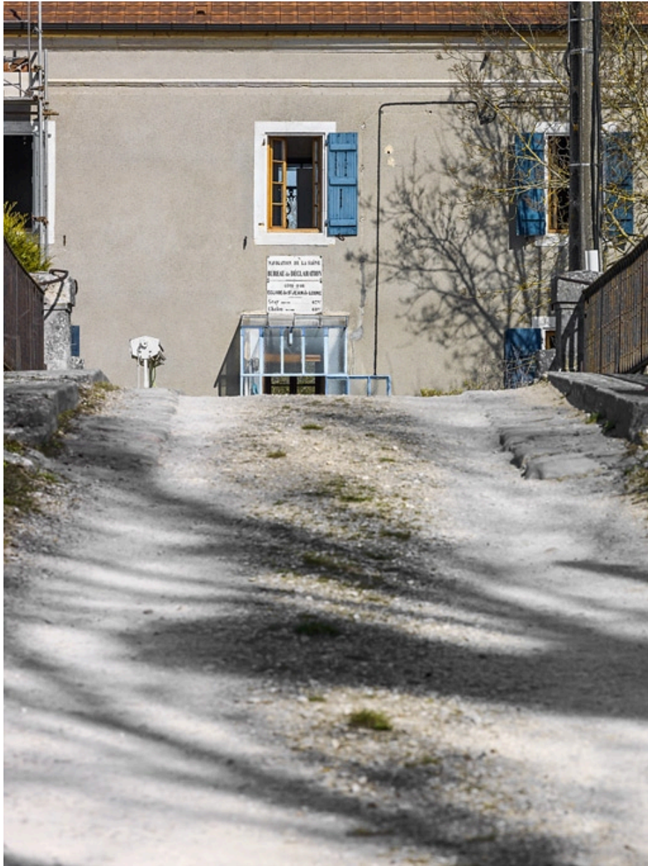
Maison éclusière : vue rapprochée sur la plaque.
