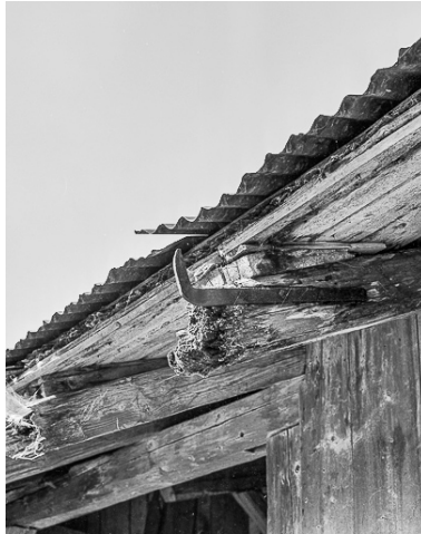
Détail de la couverture. Phot. Dominique Dominguez IVR43_19792500973X
