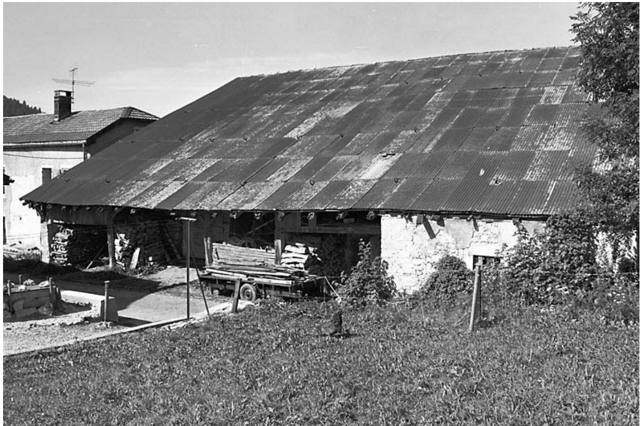
Mur goutterot et toiture.
