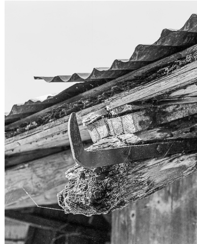
Détail : crochet en fer qui soutenait le chéneau en bois. Phot. Dominique Dominguez IVR43_19792500974X
