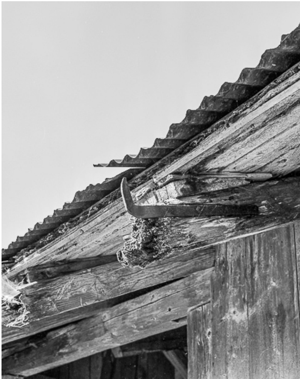
Détail de la couverture.
