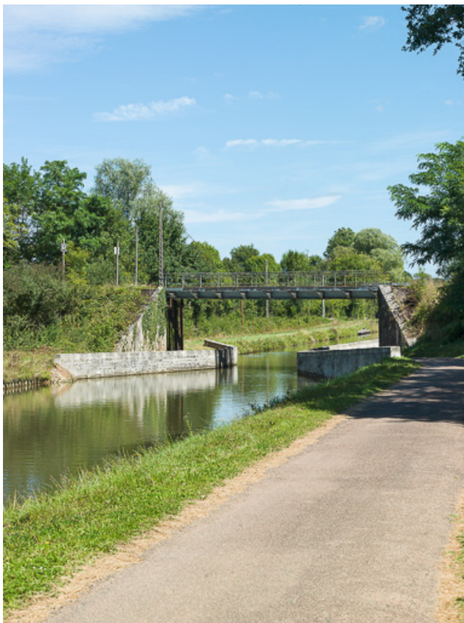
Vue d'ensemble du pont.
