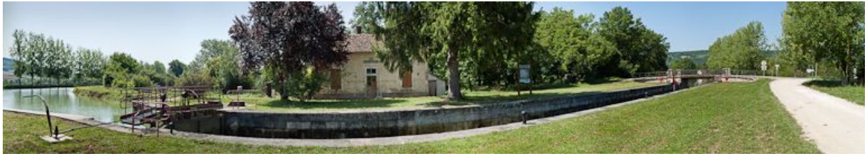
Vue d'ensemble du site d'écluse.
