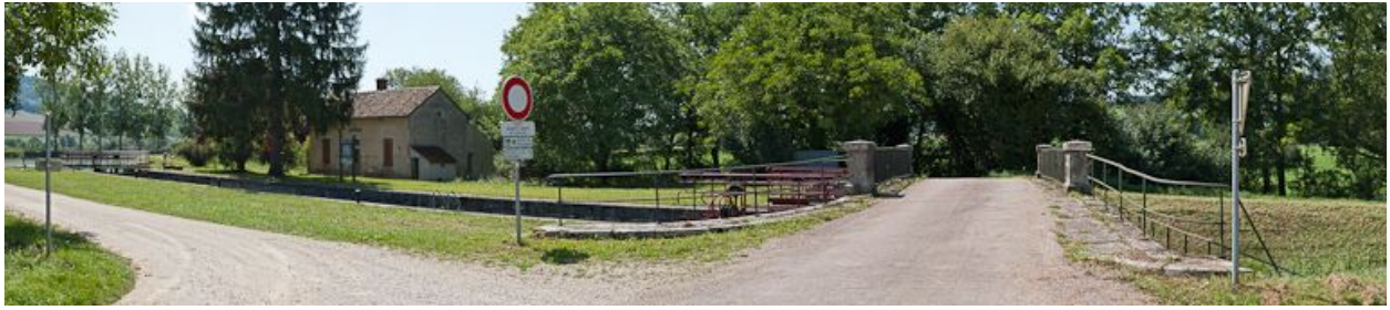
Vue d'ensemble du site d'écluse.
