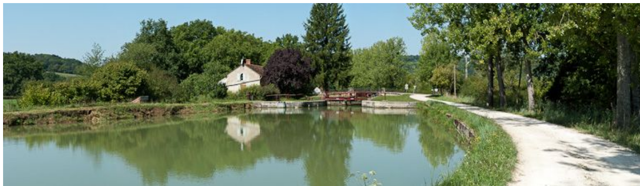
Vue du site d'écluse depuis l'amont.
