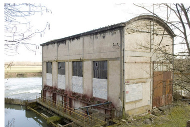
La centrale hydroélectrique vue depuis le nord. Phot. Jérôme Mongreville IVR43_20097000247NUC2A
