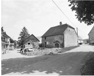
Façade postérieure. Phot. Yves Sancey IVR43_19813900232X
