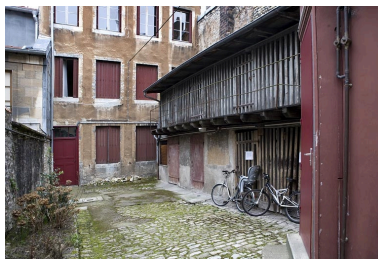
Détail du rez-de-chaussée de la façade postérieure du premier logis secondaire et des bûchers situés dans la deuxième cour.
