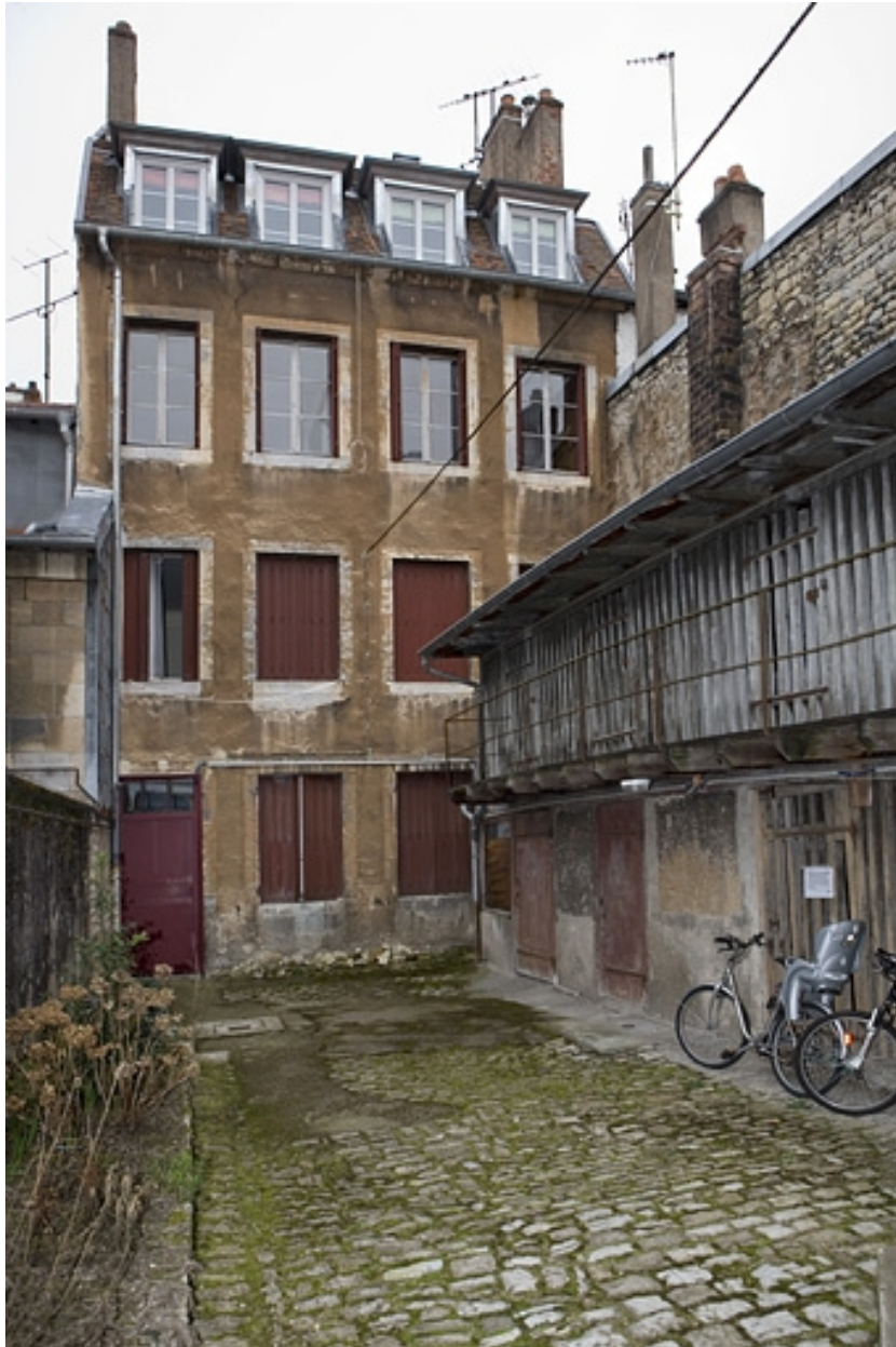
Vue d'ensemble de la façade postérieure du premier logis secondaire et des bûchers situés dans la deuxième cour.
