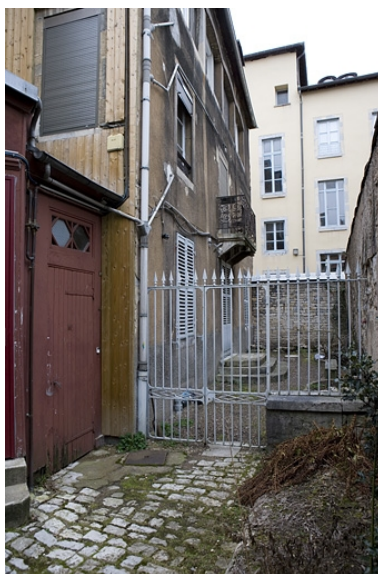
Vue d'ensemble de la façade antérieure du deuxième logis secondaire située dans la troisième cour.
