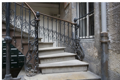
Détail du départ de l'escalier à cage ouverte, vue horizontale. Phot. Yves Sancey IVR43_20092500174NUC2A
