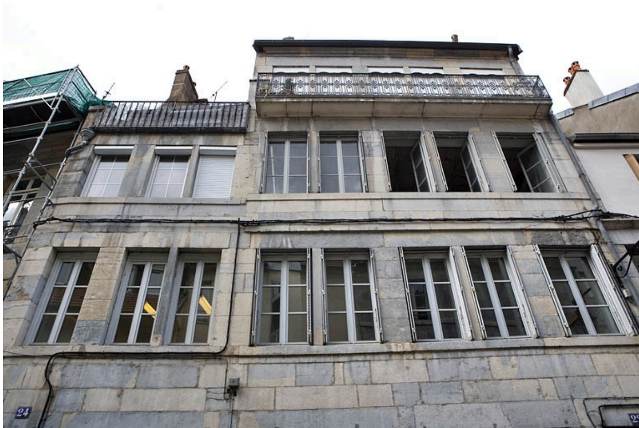
Détail des derniers étages de la façade principale, de face.
