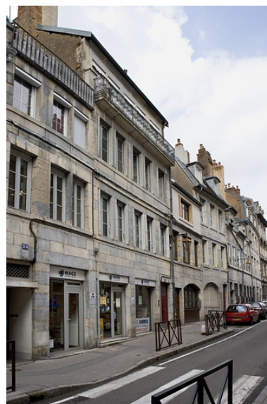
Vue d'ensemble rapprochée de la façade principale dans l'alignement de la rue. Phot. Yves Sancey IVR43_20092500171NUC2A
