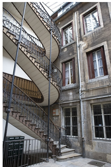
Détail de l'escalier à cage ouverte et de la façade antérieure du premier logis secondaire. Phot. Yves Sancey IVR43_20092500176NUC2A
