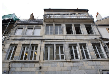
Détail des derniers étages de la façade principale, de face. Phot. Yves Sancey IVR43_20092500172NUC2A
