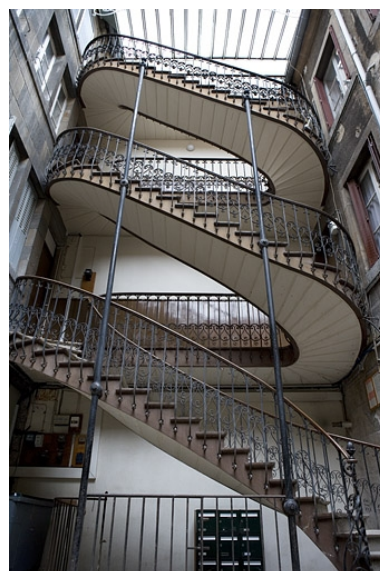
Vue d'ensemble de l'escalier à cage ouverte, de face. Phot. Yves Sancey IVR43_20092500173NUC2A
