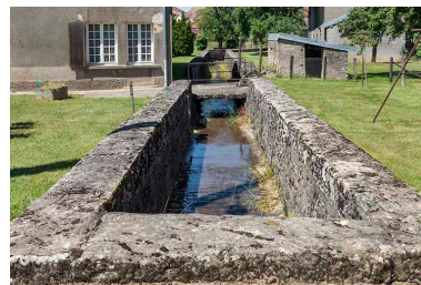
Le ruisseau canalisé qui traverse le village. Phot. Jérôme Mongreville IVR43_20177000825NUC4A
