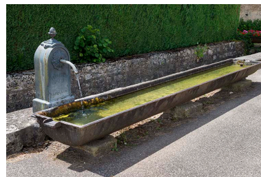
Borne-fontaine et auge d'abreuvoir en fonte situées route de Port-sur-Saône. Phot. Jérôme Mongreville IVR43_20177000822NUC4A
