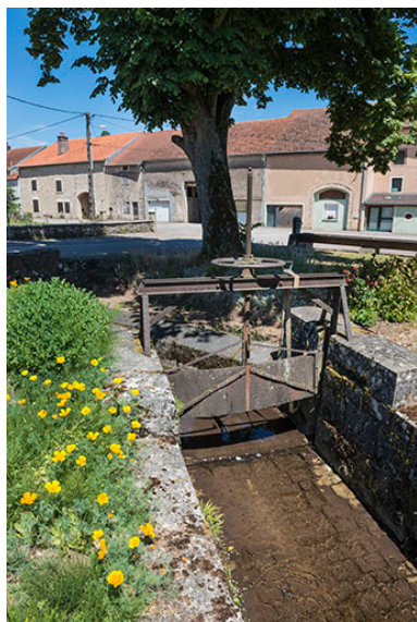
Vanne située à l'extrémité sud du village. Phot. Jérôme Mongreville IVR43_20177000773NUC4A
