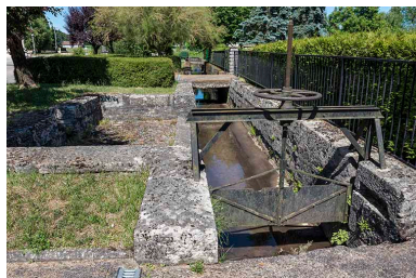
Détail de la vanne située en aval sud de la remise de matériel d'incendie et d'un lavoir en pierre. Phot. Jérôme Mongreville IVR43_20177000827NUC4A
