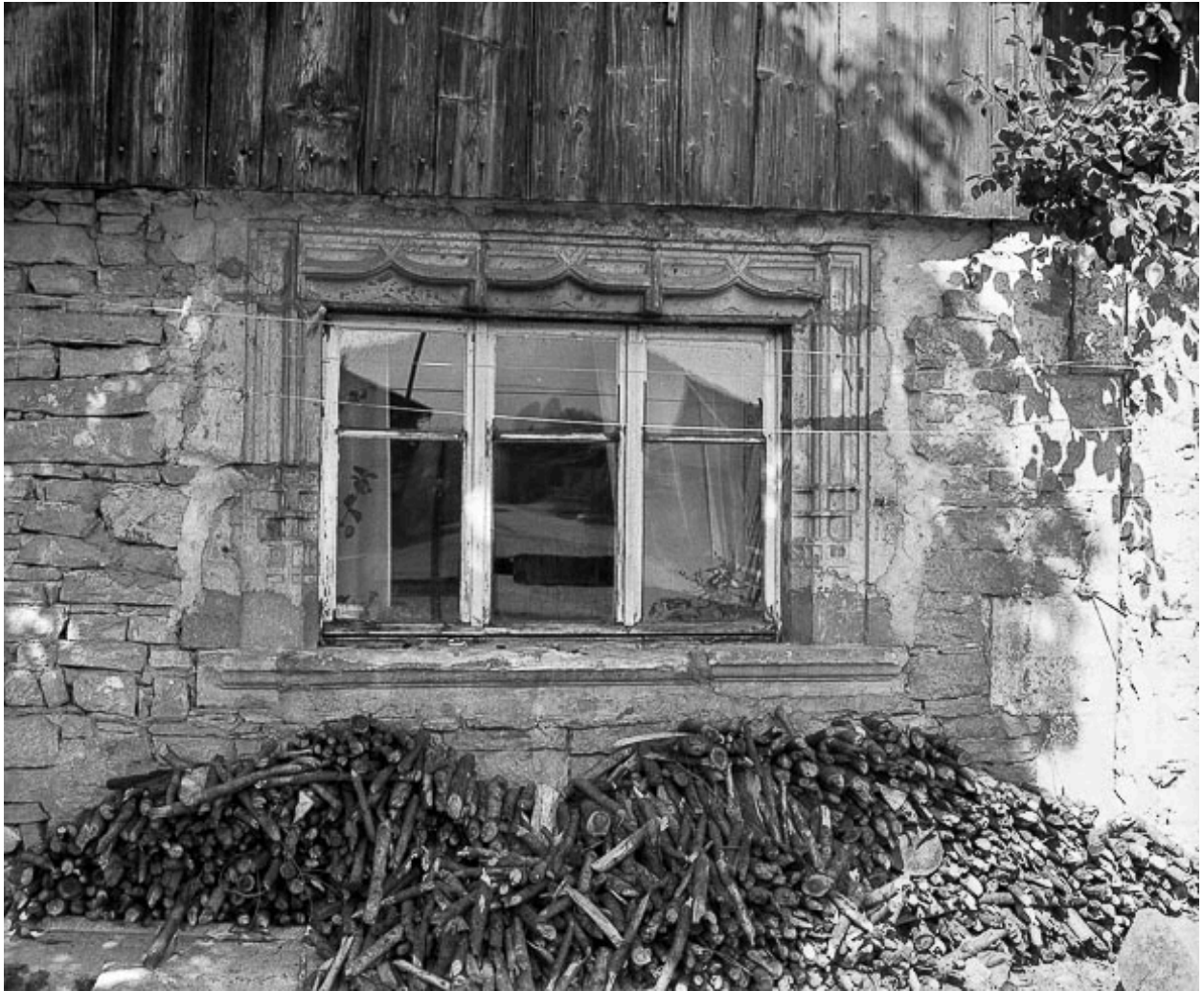
Façade antérieure : fenêtre.
