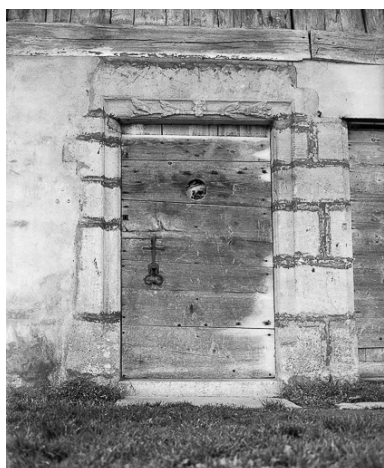
Extérieur : porte sur le mur gouttereau. Phot. Dominique Humbert IVR43_19762500643X
