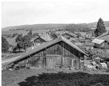
Façade postérieure. Phot. Yves Sancey IVR43_19762500737V
