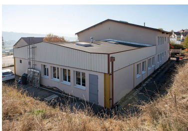
Vue plongeante, depuis le nord. Phot. Sonia Dourlot IVR43_20182501592NUC4A
