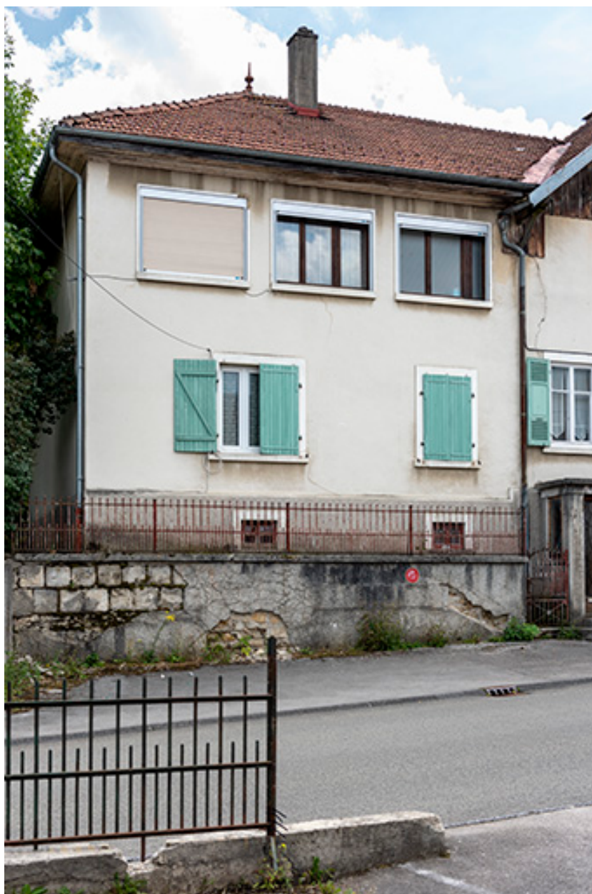
Maison : atelier de fabrication dans l'extension.
