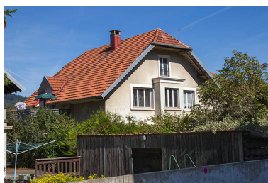
Maison : façade postérieure, de trois quarts gauche. Phot. Yves Sancey IVR43_20132502448NUC2A
