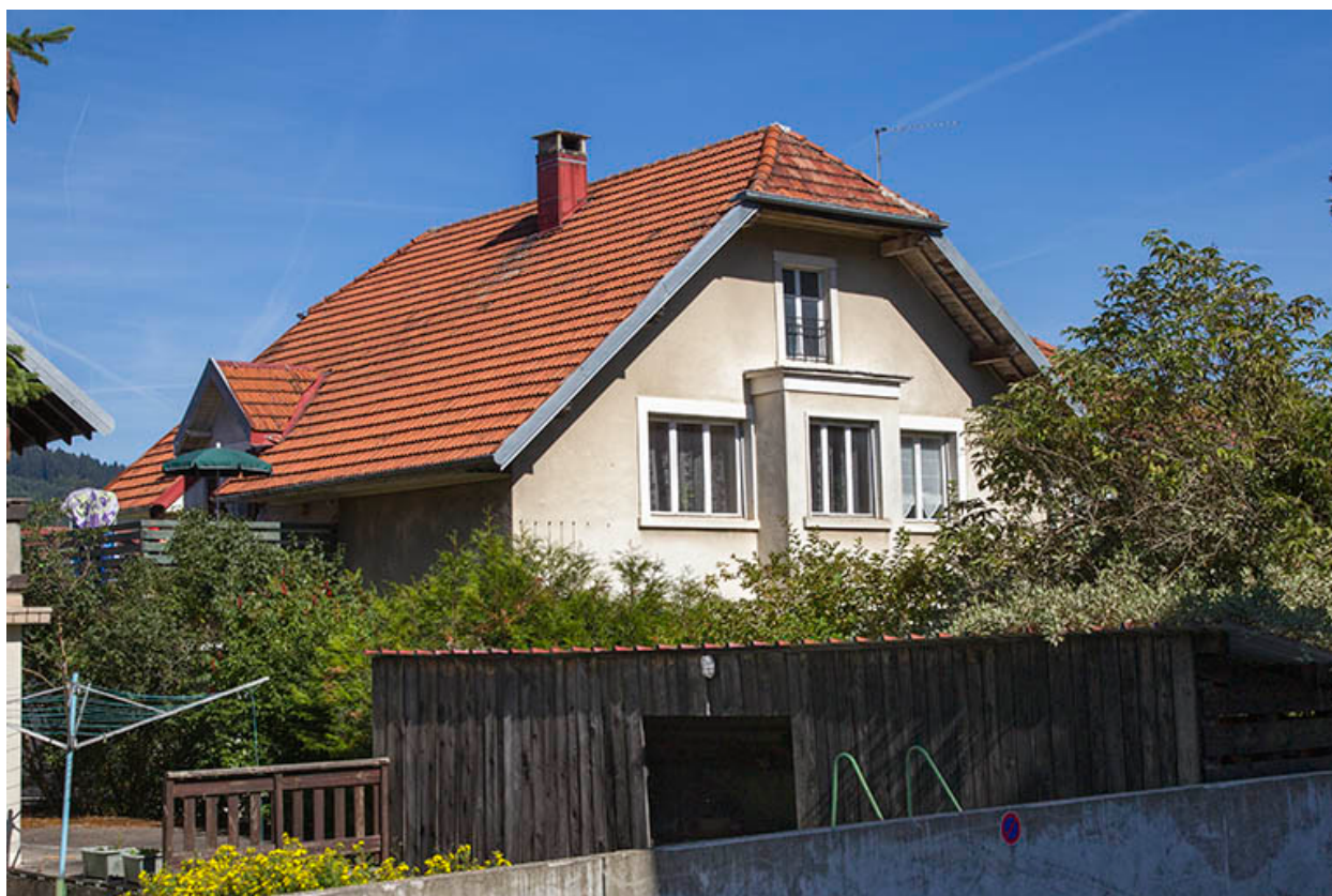
Maison : façade postérieure, de trois quarts gauche.
