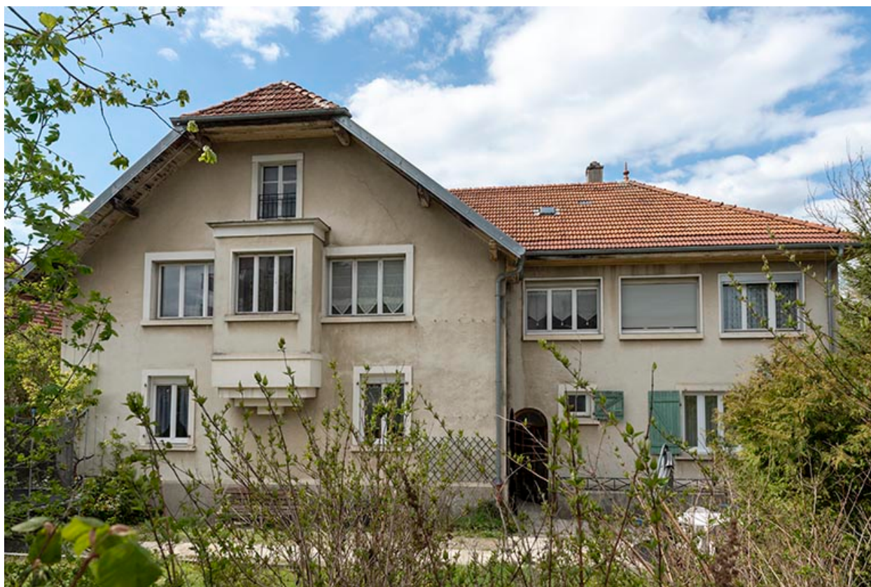
Maison et atelier de fabrication : façade postérieure.
