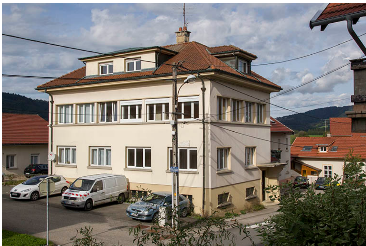
Usine : façades antérieure et latérale gauche.
