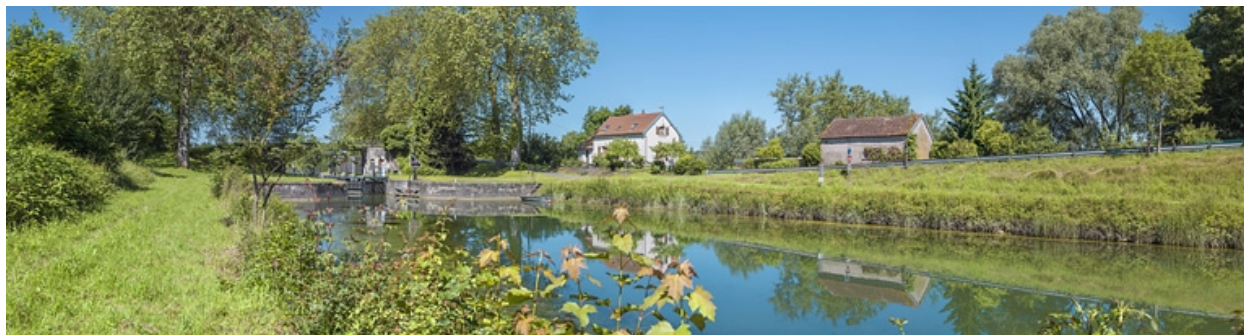
Vue d'amont. Maison éclusière à droite.
