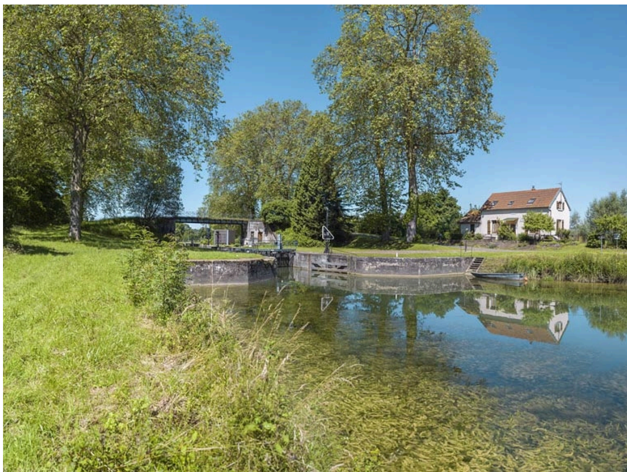
Vue d'amont. Maison éclusière à droite.
