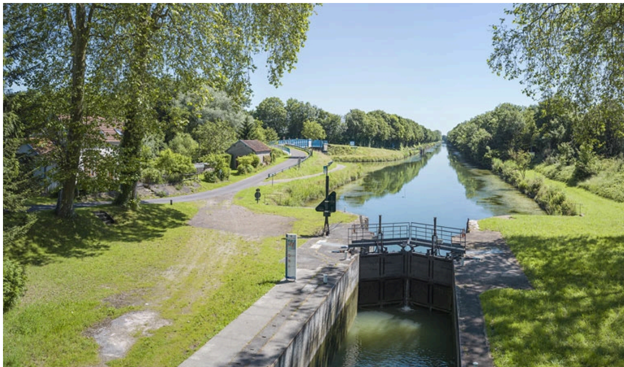
Vue des portes amont et du sas depuis le pont sur écluse.
