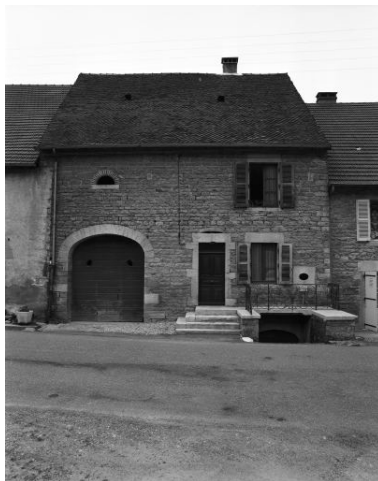
Façade antérieure en 1981. Phot. Yves Sancey IVR43_19813900209X
