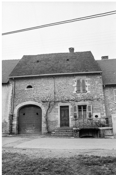
Façade antérieure en 1974. Phot. F. Pernin IVR43_19743900033Z
