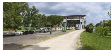
Vue d'amont. Phot. Thierry Kuntz IVR26_20137100286NUC4A
