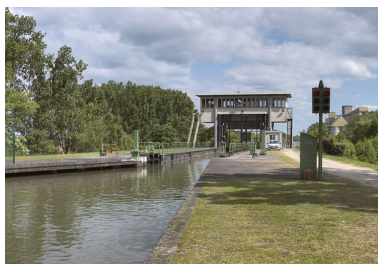
Vue d'amont. Phot. Thierry Kuntz IVR26_20137100288NUC4A
