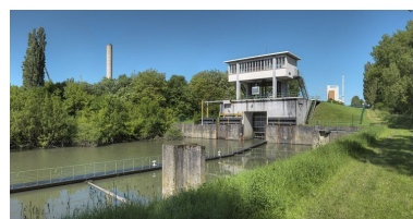
Vue d'ensemble d'aval. Phot. Thierry Kuntz IVR26_20137100279NUC4A
