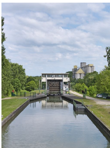
Vue d'amont. Phot. Thierry Kuntz IVR26_20137100296NUC4A
