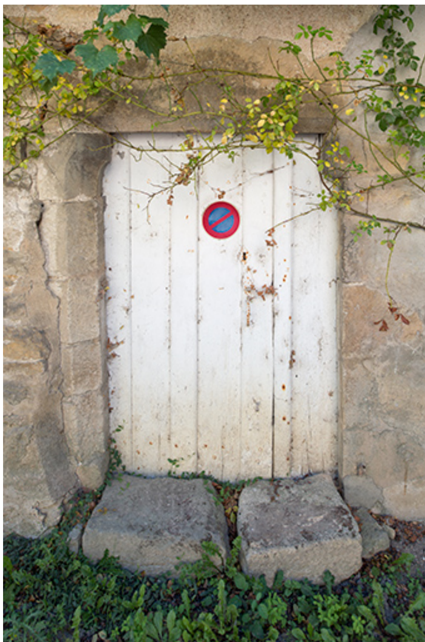
Porte du cellier de la maison de la rue du Colombier.
