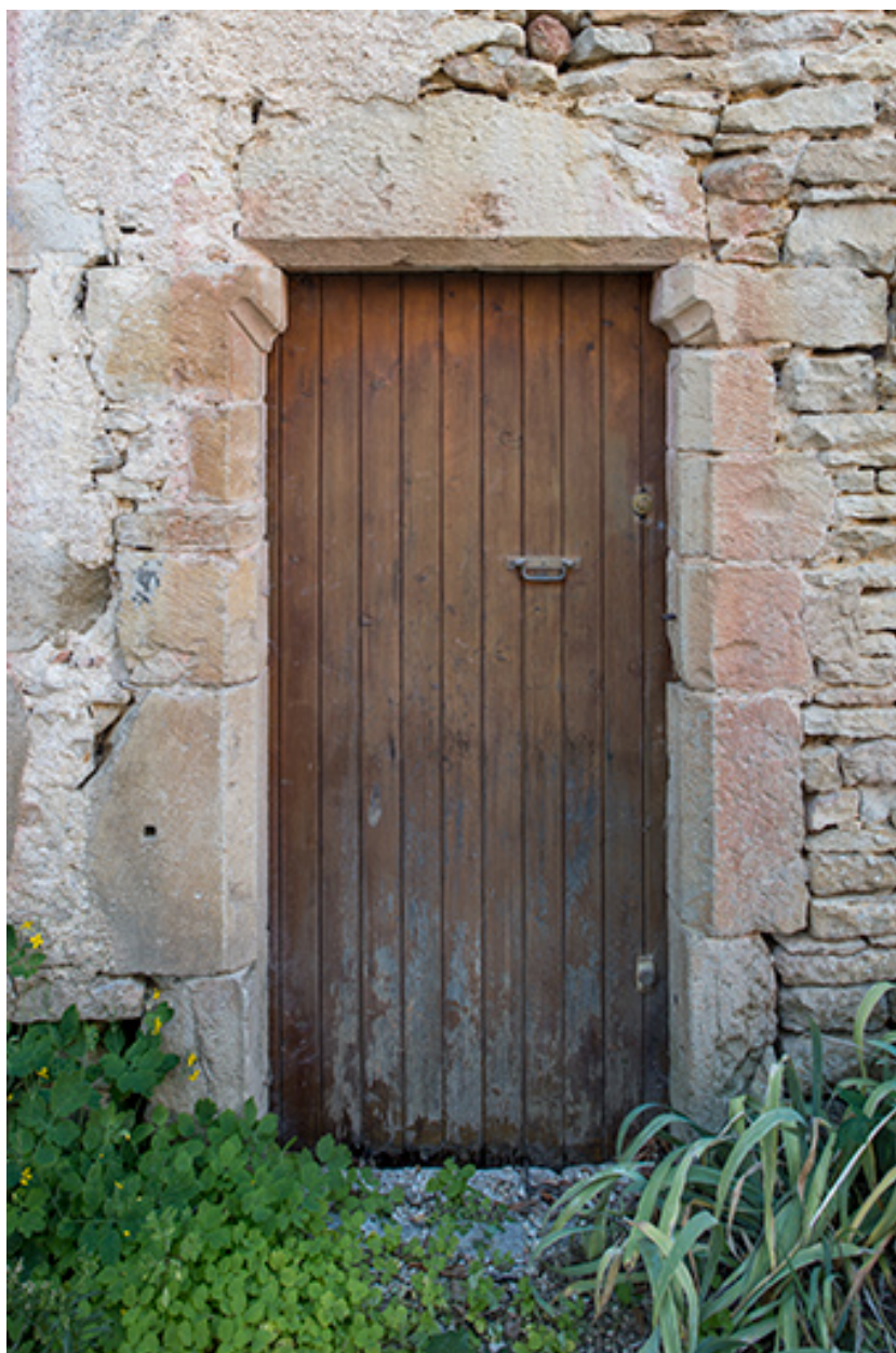
Porte en remploi de l'un des celliers.
