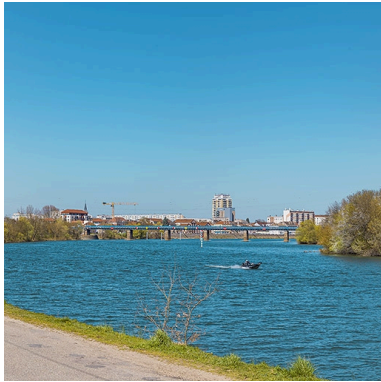
Vue d'ensemble du pont, depuis l'aval. Phot. Thierry Kuntz IVR26_20217100082NUC4A
