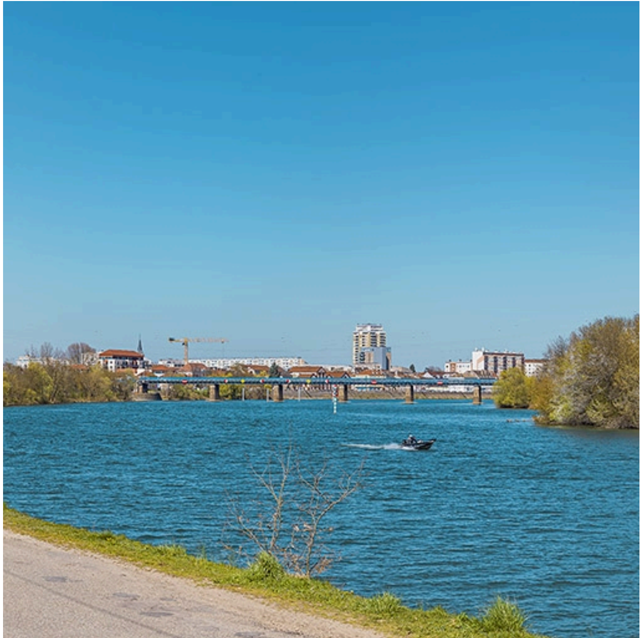
Vue d'ensemble du pont, depuis l'aval.
