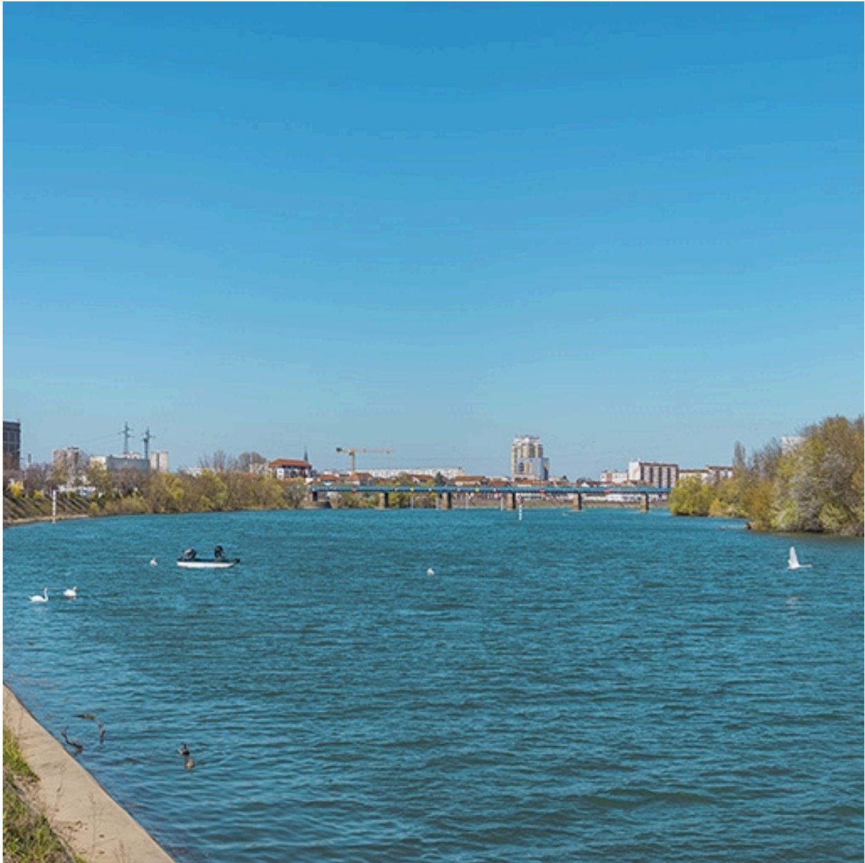
Vue d'ensemble du pont, depuis l'aval.
