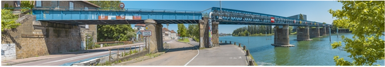
Le viaduc des Dombes : vu d'aval, rive droite.
