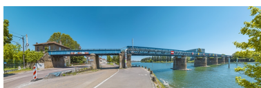
Le viaduc des Dombes : vu d'aval, rive droite. Phot. Thierry Kuntz IVR26_20217100277NUC4A
