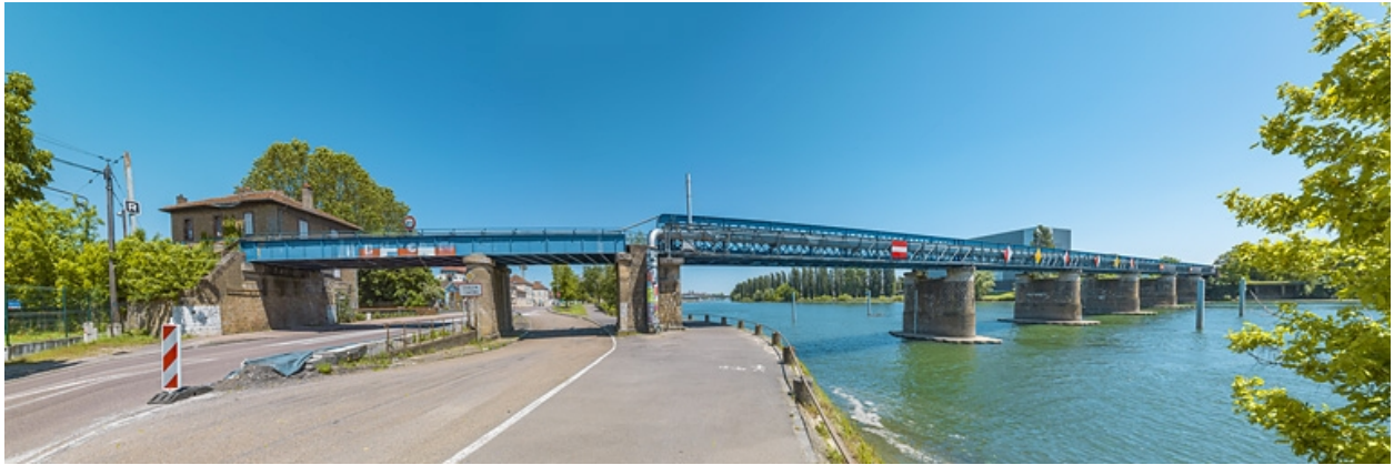
Le viaduc des Dombes : vu d'aval, rive droite.
