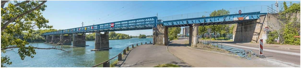
Le viaduc vu d'amont.
