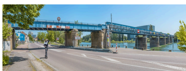
Le viaduc des Dombes : vu d'aval, rive droite. Phot. Thierry Kuntz IVR26_20217100274NUC4A
