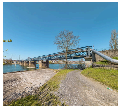
Vue d'ensemble du pont, depuis la rive gauche. Phot. Thierry Kuntz IVR26_20217100084NUC4A
