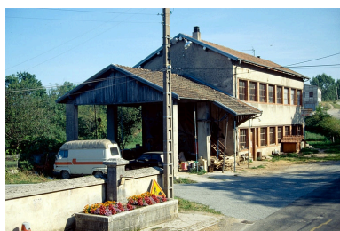
Vue d'ensemble. Phot. Laurent Poupard
