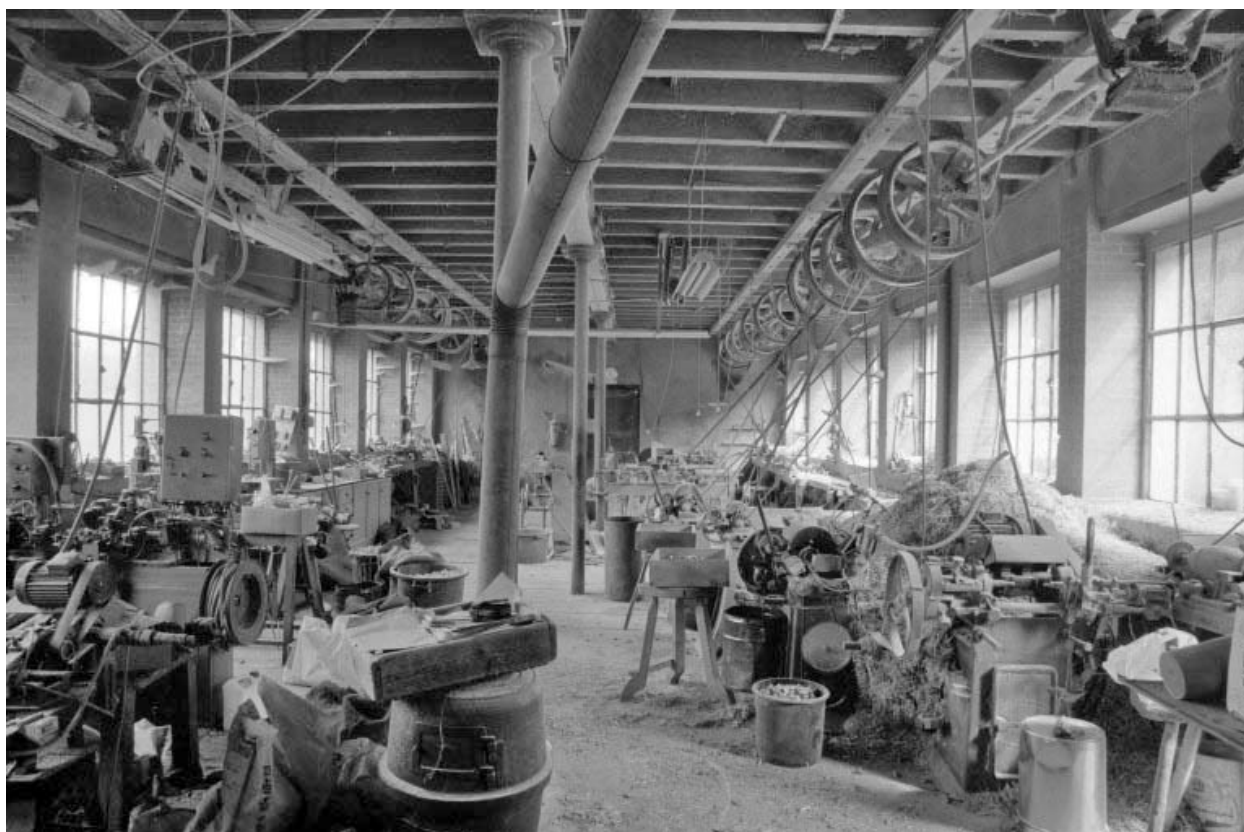
Intérieur de l'atelier de fabrication.
