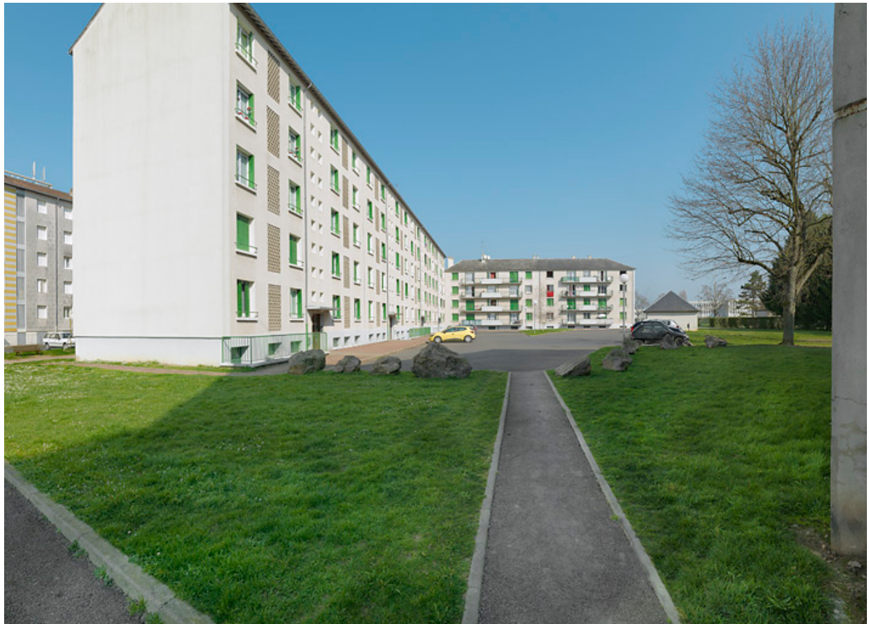
Façade antérieure est et façade postérieure sud.
